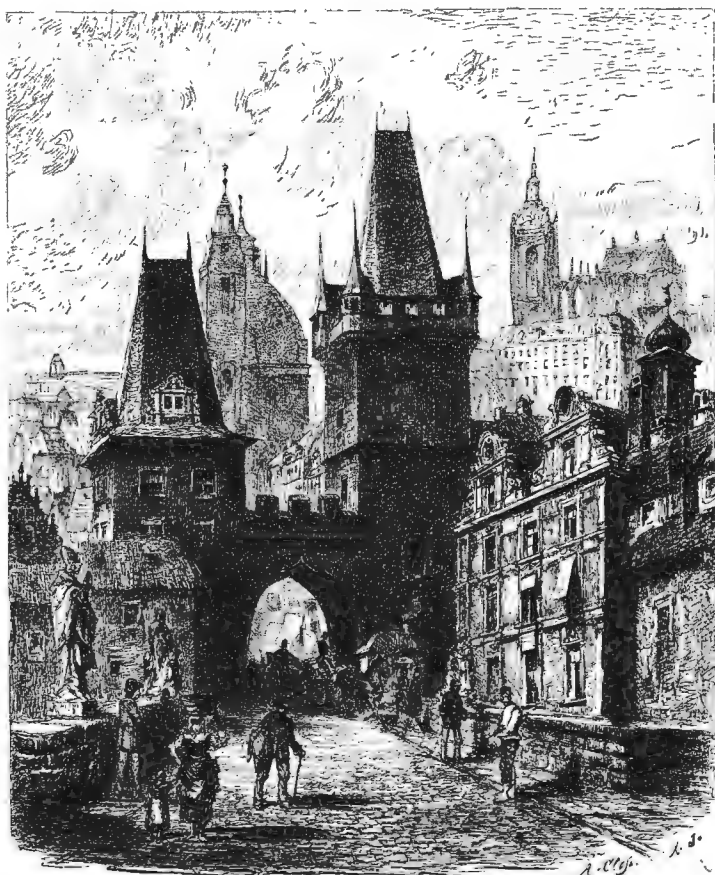
Городъ Прага. Рис. 6. Мостовыя башни Малой стороны.
