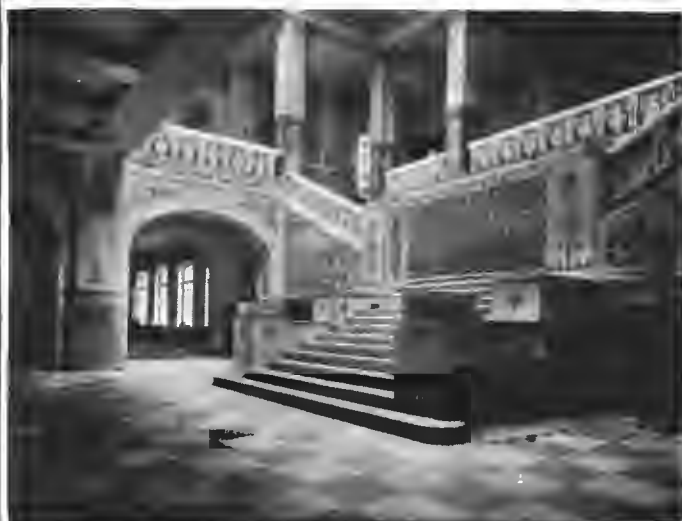
Вестибюль (нижний этажъ).
