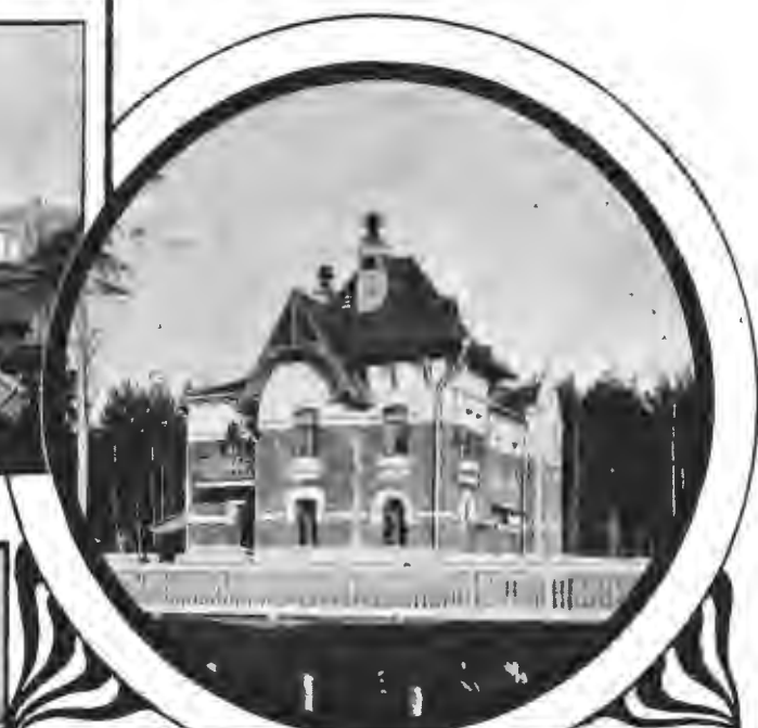
Жилой домъ на станціи Серебряный-Боръ на Московско-Окружной жел. дор.
