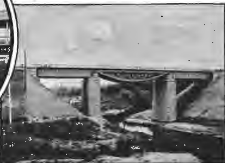
Мостъ черезъ рѣку Язу на Московско-Окружной жел. дор.
