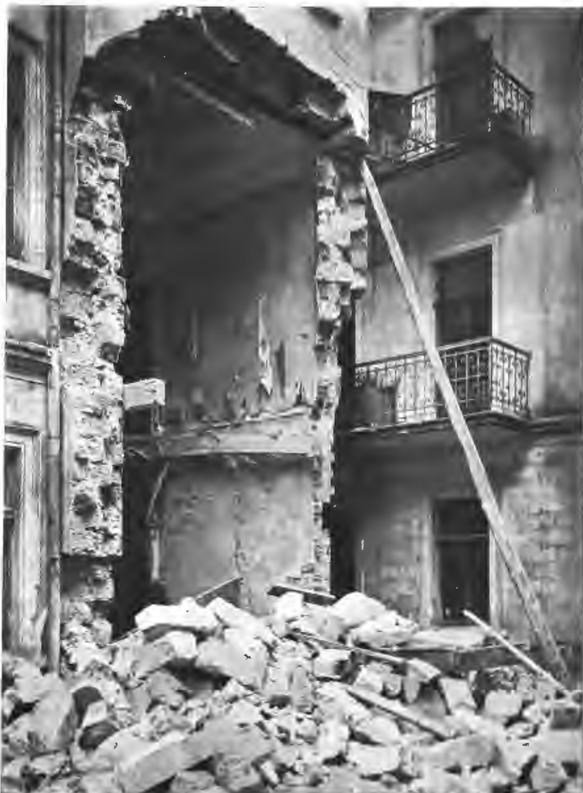
Беспорядки въ Одессѣ. Взрывъ въ домѣ Михелева по Внѣшней улицѣ, происшедшій въ ночь на 25 января с. г. отъ разорвавшихся бомбъ. Флигель разрушенъ взрывомъ. Въ первыхъ двухъ этажахъ совершенно разрушены потолокъ и полъ, а третій, уцѣлѣвшій, этажъ держится на подпоркѣ. По фот. Пудичева въ Одессѣ.
