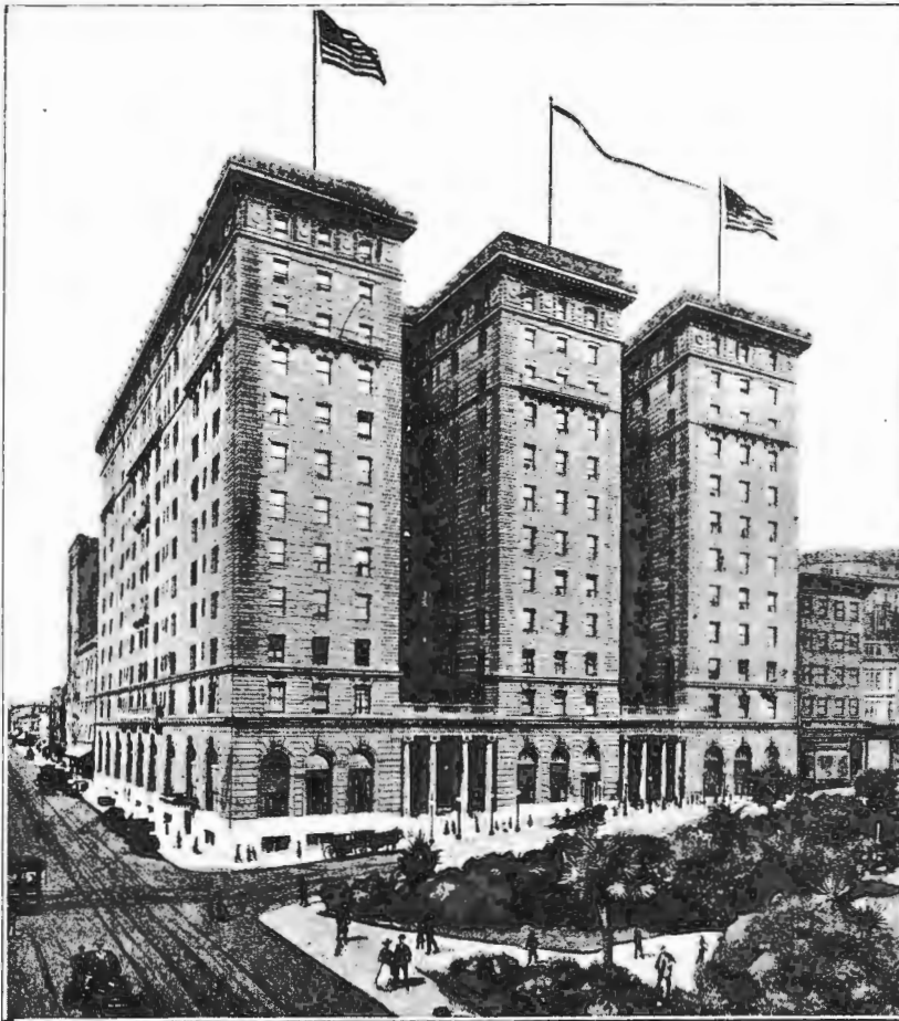
Землетрясение въ Санъ-Франциско. Одно изъ самыхъ большихъ зданій въ городѣ, разрушенное землетрясеніемъ.
