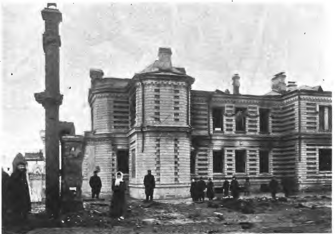
Кровавые дни въ Москвѣ. Домъ при фабрикѣ Шмита, въ которомъ жила семья фабриканта; домъ этотъ разрушенъ во время московскихъ событій. По фот. А. Завадскаго, въ Москвѣ.
