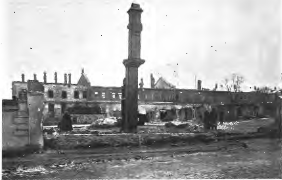
Кровавые дни въ Москвѣ. Общій видъ мебельной фабрики Шмита, разрушенной во время московскихъ событій. По фот. А. Завадскаго, въ Москвѣ.
