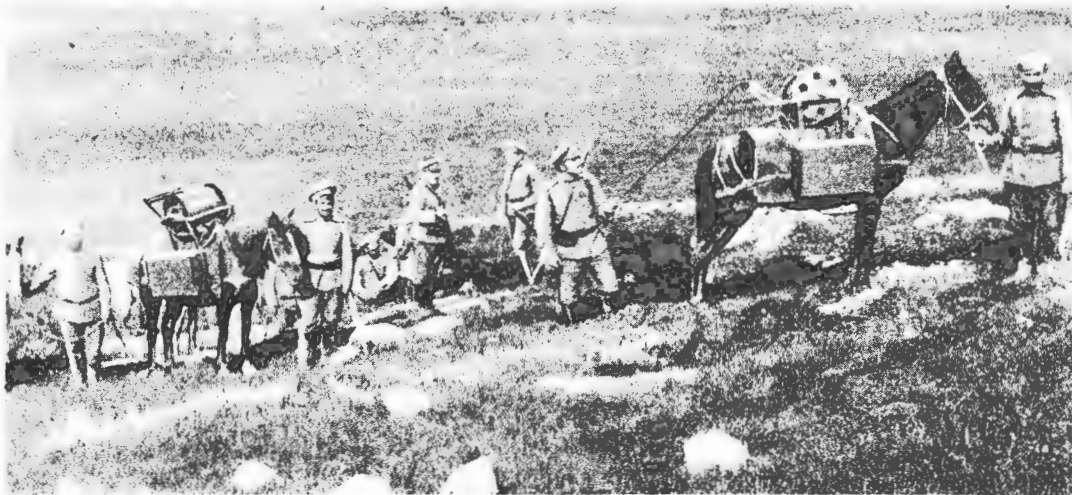
Прокладка телефонной линии въ горахъ.
