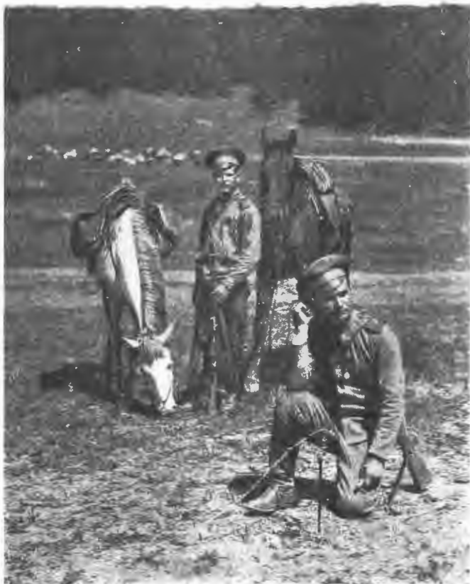
Прокладка телефонной линии. „Слушаю“.
