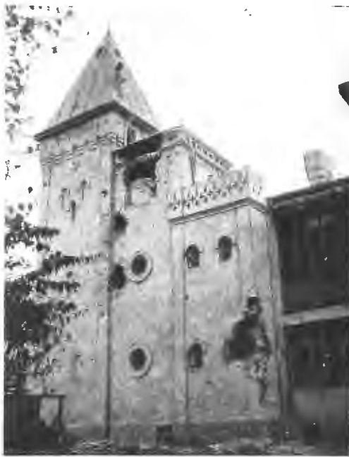
Около города Рудника. Господскій домъ, поврежденный снарядами.
