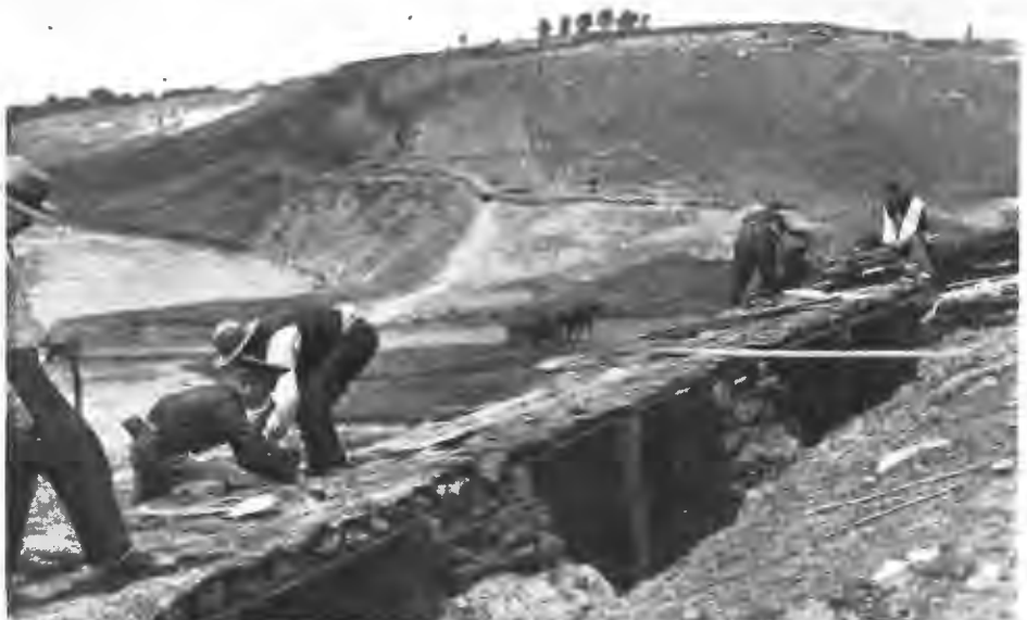
Постройка окоповъ мѣстными жителями подъ руководствомъ нижнихъ чиновъ.
