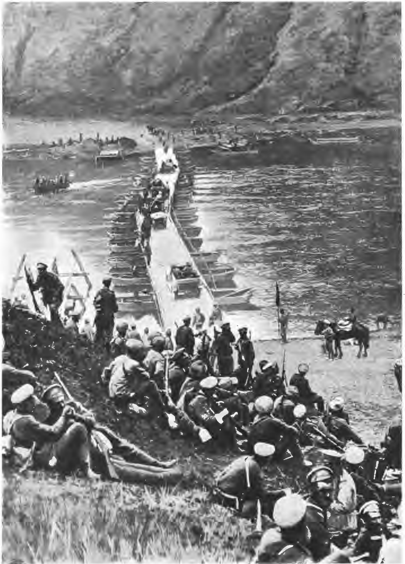
Изъ дѣйствующей арміи. У понтоннаго моста.
