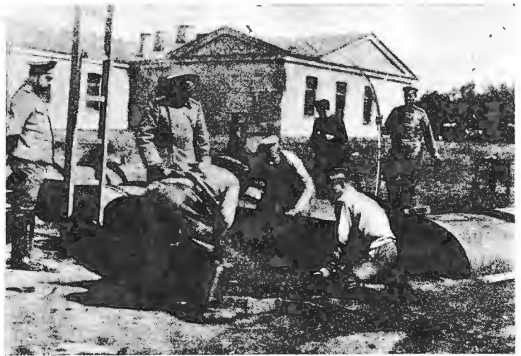
Изобрѣтеніе русскаго солдата. Тихонъ Кавунъ приспособилъ реквизируемые котлы отъ спирта для хлѣбныхъ печей. Печи Кавуна, весьма легкія (21 п.), удобныя для перевозки, приобрѣли популярность на войнѣ.
