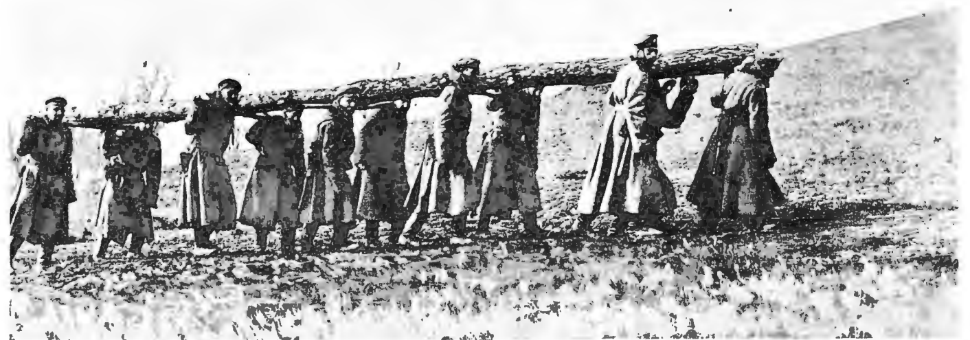
Работы по сооруженію моста
