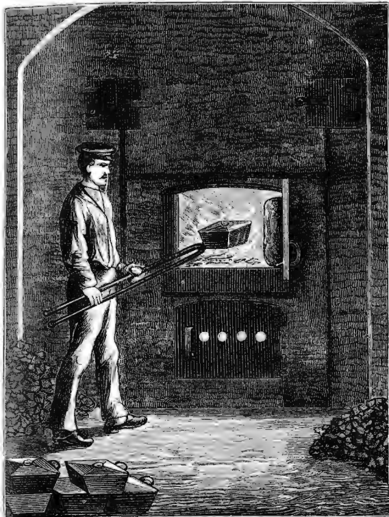
Рис. 4. Накаливаніе стальныхъ полосъ.
