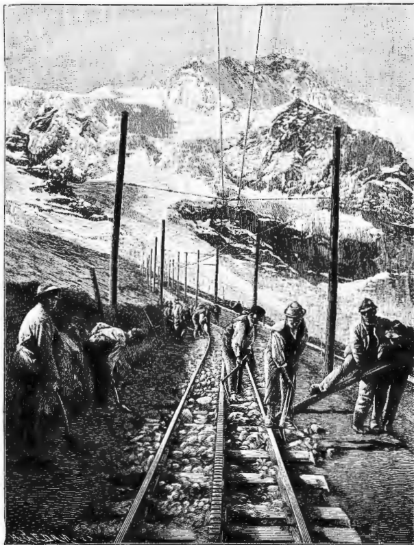
Рис. 2. Рельсовый путь на Юнгфрау. Укладка пути щебнемъ.
