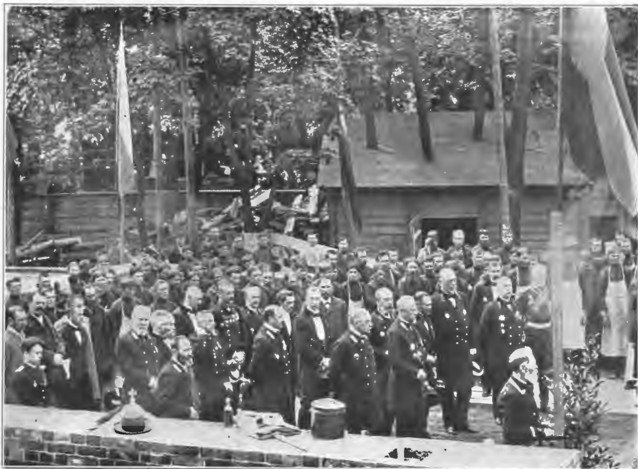
Закладка музея Императора Николая I, сооружаемого министерствомъ путей сообщенія въ Петербургѣ, на Садовой ул. у Юсупова сада По фот. К. К. Булга авт. «Нивы».
