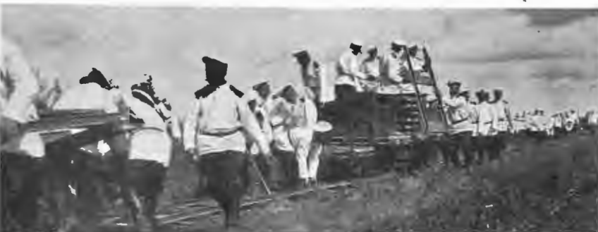
Въ Усть-Ижорскомъ лагерѣ. Укладка рельсъ крѣпостной узкоколейной жел. дор. По фот. К. Булла, авт. «Нивы».
