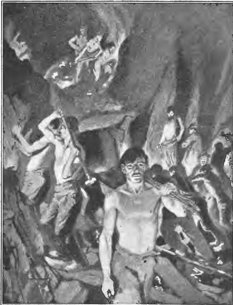
Прорытіе Симплонскаго тунеля. Подземныя работы. По фот. авт. «Нивы».
