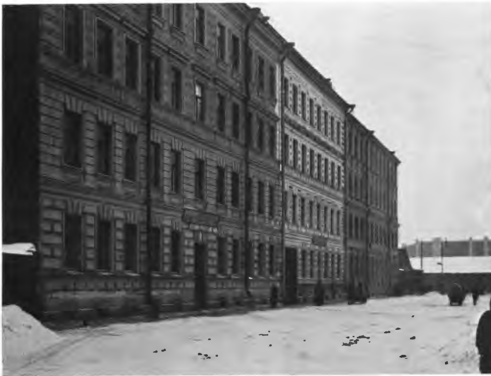
Зданіе типографіи Градоначальства, 2-й роты городскихъ и 1-го Отдѣленія Конно-полицейской стражи по 8 ротѣ Измайл. полка, д. № 20. 1902 г.
