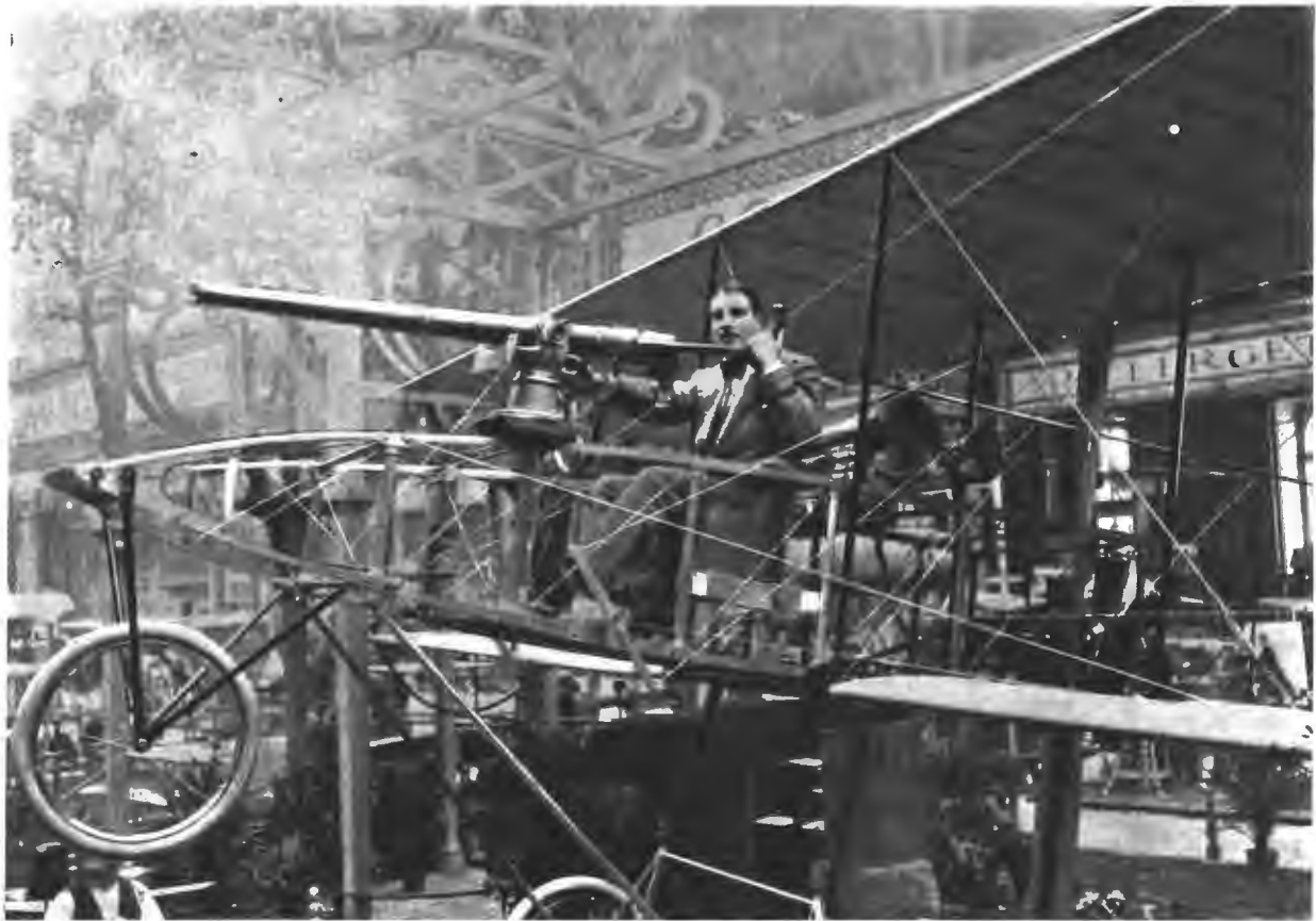
Скорострѣльное артиллерійское орудіе небольшого калибра, установленное на аэронавѣ Вуазена.
