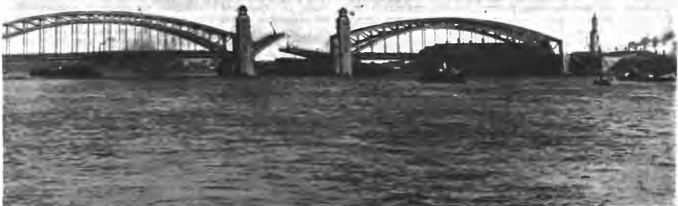
Вновь выстроенный въ С.-Петербургѣ Охтенскій мостъ имени Петра Великаго. Разводная часть моста. По фот. К. Булла.
