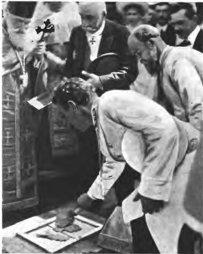
Закладка здания городского народного университета имени А. Л. Шанявского на Мясницкой площади в Москве, 24 июля с. г. Момент закладки.
