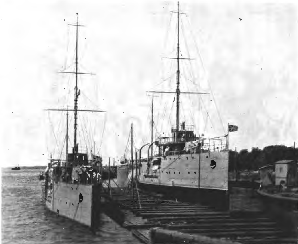
Канонерскія лодки „Карсъ“ и „Араганъ“, предназначенныя для несенія военной службы на Каспійскомъ морѣ и прошедшія изъ Петербурга, гдѣ онѣ были построены, въ Каспійское море по системѣ рѣкъ и каналовъ. Канонерка „Карсъ“ была поднята въ Астрахани въ пловучій докъ Т-ва Бр. Нобель для исправленія нѣкоторыхъ поврежденій, полученныхъ ею въ пути. Канонерка „Араганъ“—рядомъ на водѣ. По фот. К. М. Губина въ Астрахани.
