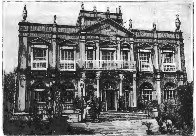
Зданіе французскаго консульства въ Тянь-Цзинь, которому угрожали мятежники. По фот. грав. Хелмицкій.
