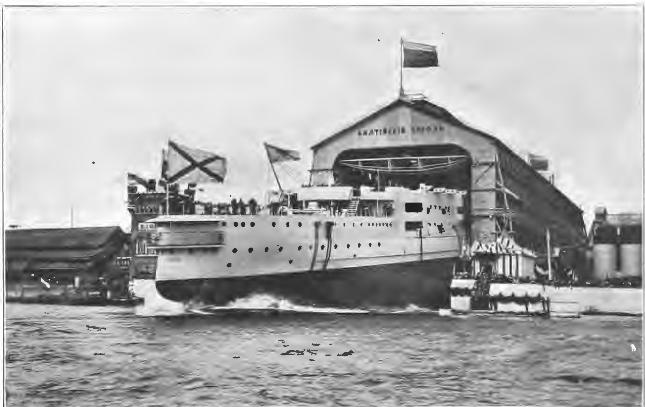
Спускъ на воду на Балтійскомъ судостроительномъ заводѣ новаго эскадреннаго броненосца „Победа“. По фот. К. Булла авт. «Нивы».
