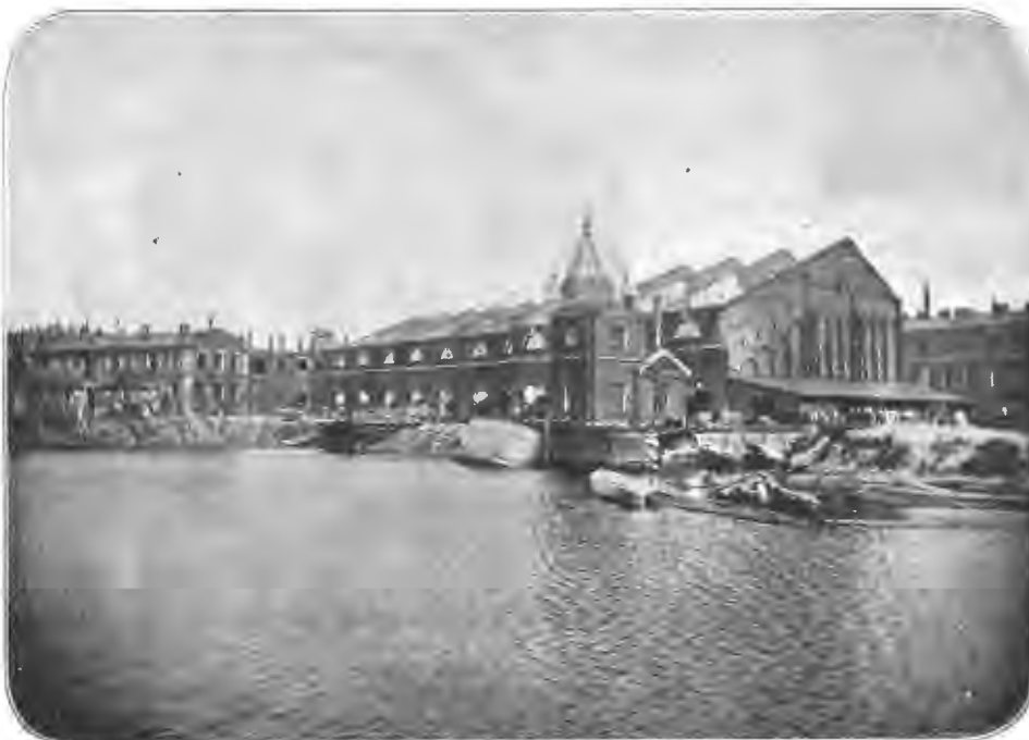
Пожаръ на островѣ „Новая Голландiя“ въ Петербургѣ, 27 мая т. г. Общiй видъ зданiй послѣ пожара. По фот. ген. А. А. Насвѣтевича авт. «Нивы».
