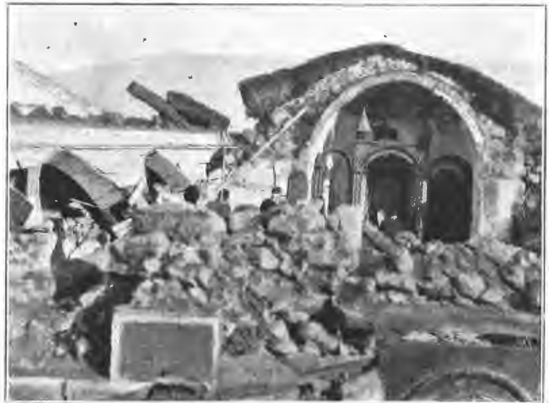
Землетрясение (19-го декабря 1899 г.) на Кавказѣ. Разрушенная армяно-грегоріанская церковь съ уцѣлѣвшимъ алтаремъ въ селеніи Меренія. По фот. Егіазарова въ Ахалкалакахъ авт. «Нивы».
