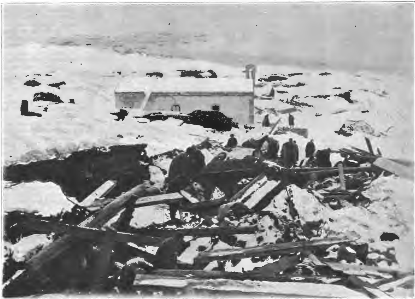
Землетрясеніе (19-го декабря 1899 г.) на Кавказѣ. Растрескавшіяся стѣны церкви и разрушенные дома въ селеніи Малый Самсаръ. По фот. Егіазарова въ Ахалкалакахъ авт. «Нивы».
