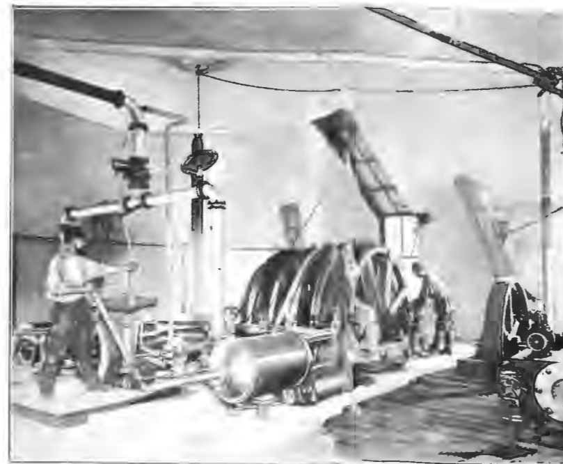
Рис. 5. Паровая машина для подъема соли изъ рудника. Автотипія „Нивы“. Илецкое соляное мѣсторожденіе и его разработка. Съ фот. К. А. Фишеръ.
