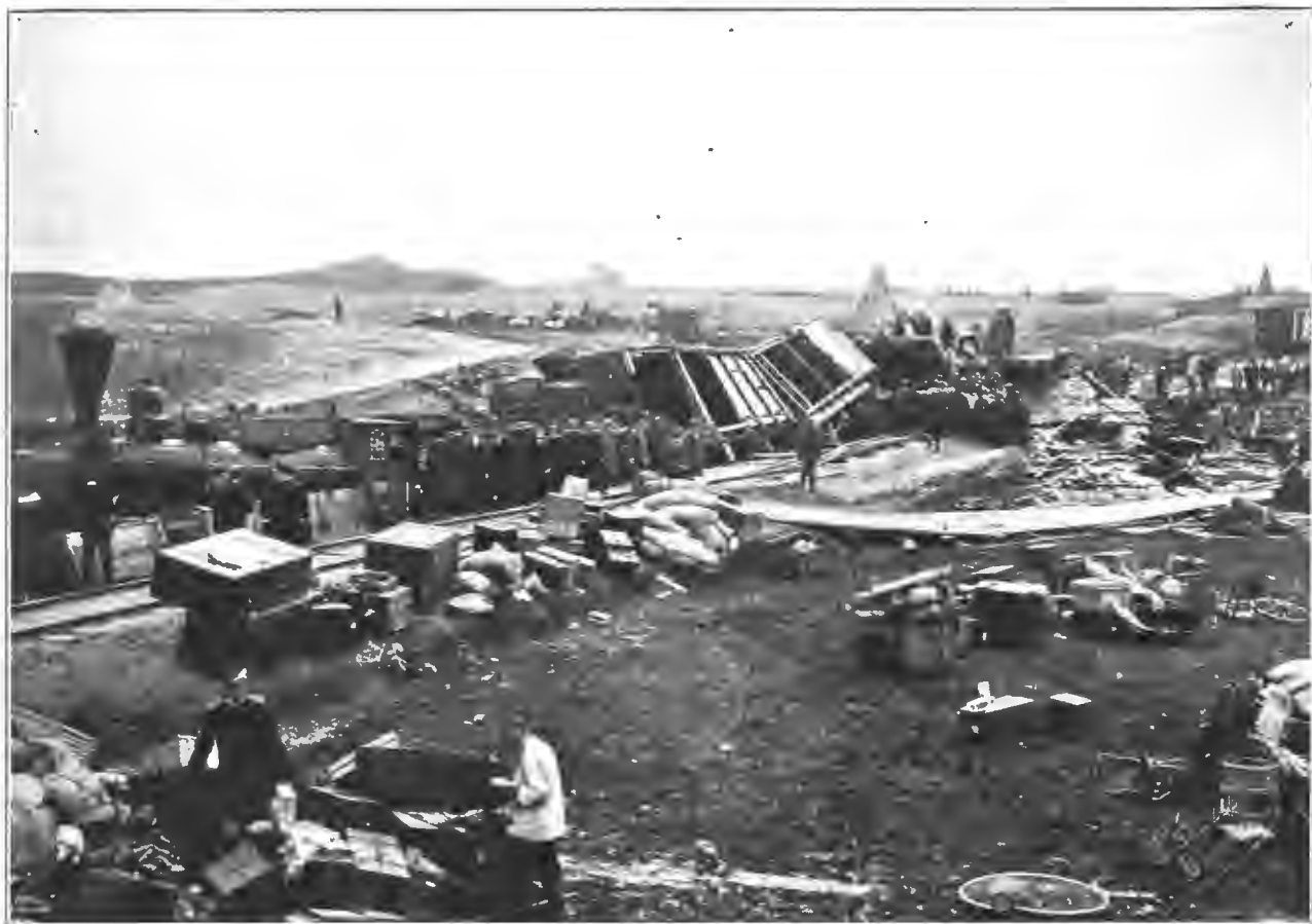
Крушение воинского поезда на псково-рижской жел. дорогѣ, близъ станціи Бокенгофъ. Соседній съ пути паровозъ и наиболее пострадавшіе при крушеніи первыя ближайшіе къ паровозу вагоны. Разборка обломковъ и вытаскиваніе клады. Съ фот. К. Шульда въ Юрьевѣ автотягилъ „Нивы“.
