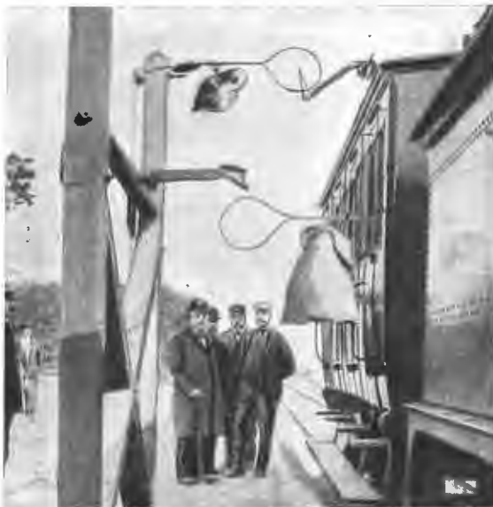
Приспособленіе для передачи почтовыхъ сумокъ на ходу поѣзда.
