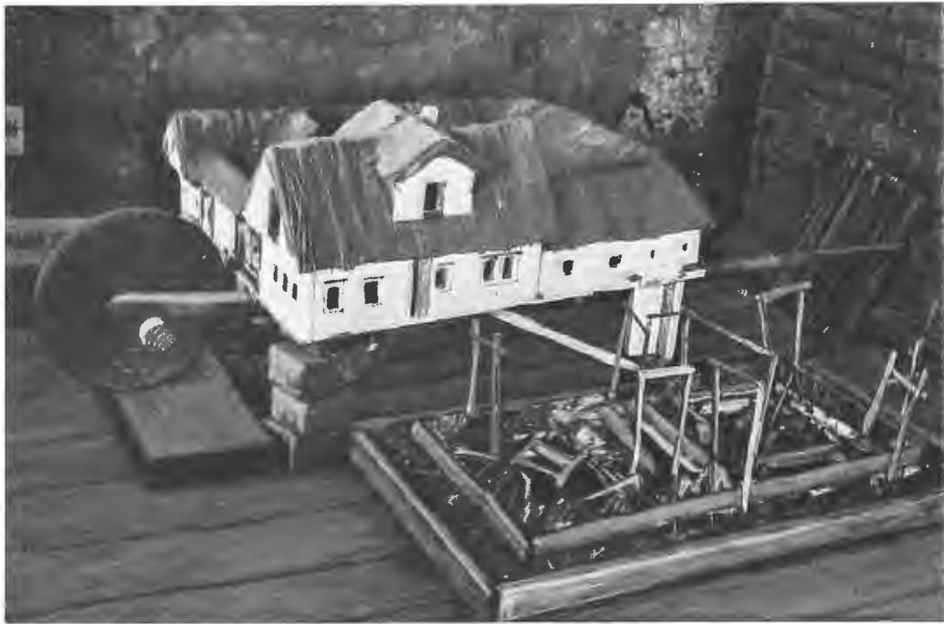
Огнестойкій поселокъ на казанской выставкѣ. Модель огнестойкой усадьбы, установленная на тачкѣ для удобнѣйшей демонстраціи по деревнямъ. Рядомъ—модельная кладка стѣны огнестойкой постройки.
