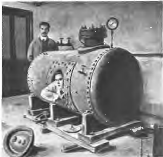
Испытаніе дѣйствія на организмъ усиленнаго давленія воздуха надъ человекомъ, заключеннымъ въ плотно-закрытомъ котлѣ.
