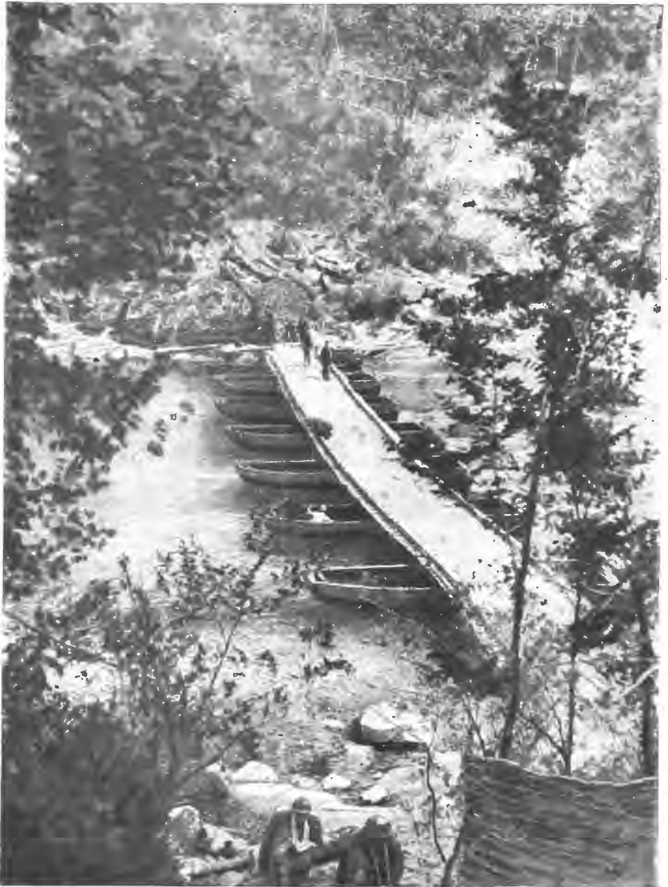
На итальянскомъ фронтѣ. Наводка понтонныхъ мостовъ черезъ рѣку Изонцо, въ Гориции, гдѣ происходило постепенное наступленіе итальянцевъ на австрійскія позиціи въ горахъ Монте-Санто и Монте-Габріэле, и откуда затѣмъ началось сокрушительное контръ-наступленіе огромныхъ австро-германскихъ силъ въ глубь Италіи, въ Венеціанскую область. Десятки такихъ понтонныхъ мостовъ были наведены итальянскими войсками въ одну ночь подъ свѣтомъ вражескихъ прожекторовъ и освѣтительныхъ ракетъ, пронизывавшихъ осеннюю тьму.
