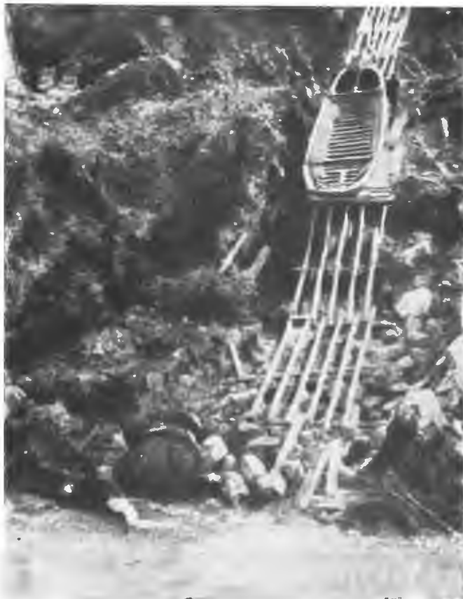
На итальянскомъ фронтѣ. Наводка понтоннаго моста черезъ рѣку Изонцо. Спускъ лодокъ.
