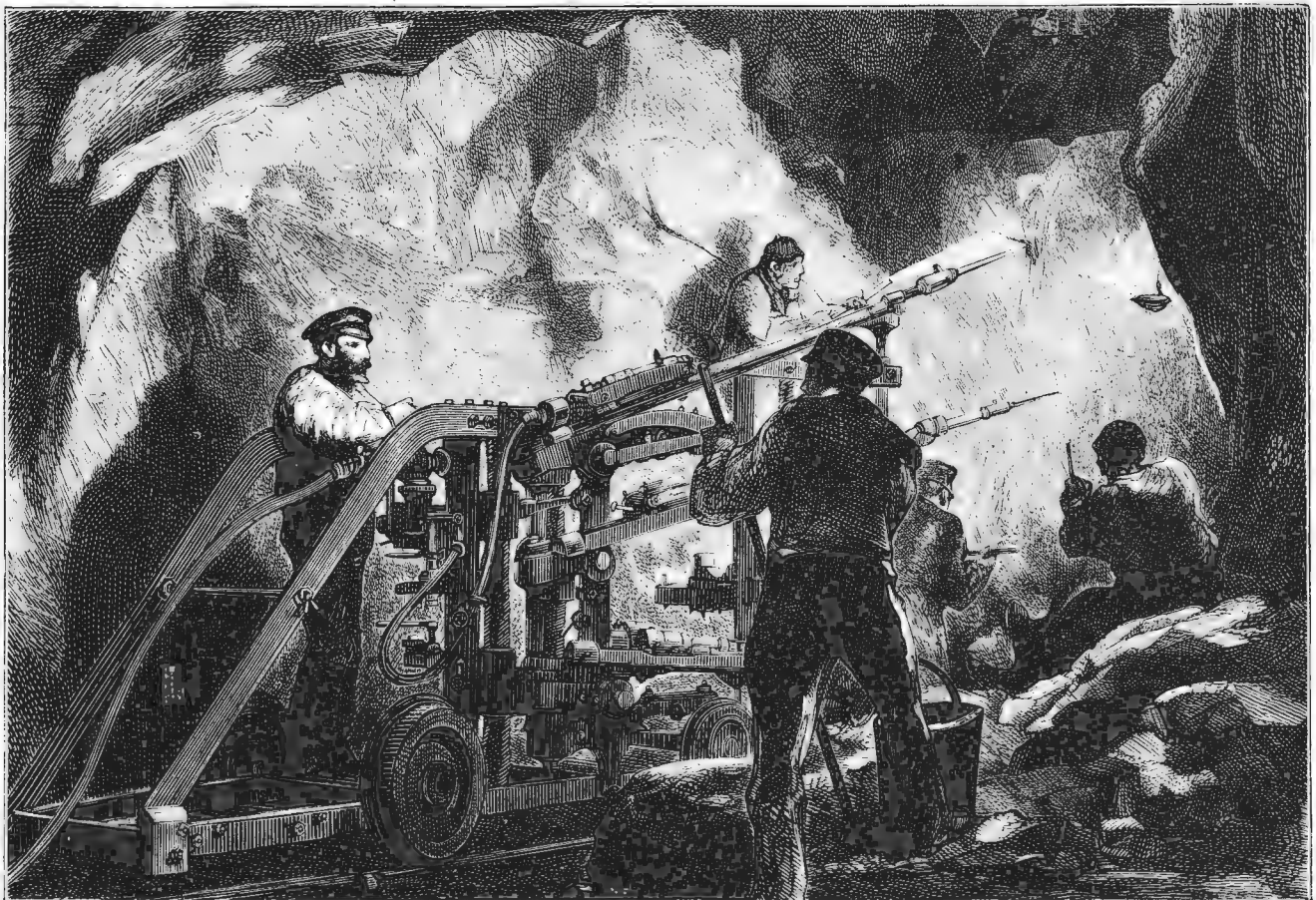
С. Готардскій туннель. Сверлильныя машины. По фотографіи Педретти въ Айролѣ, грав. М. Рашевскій.
