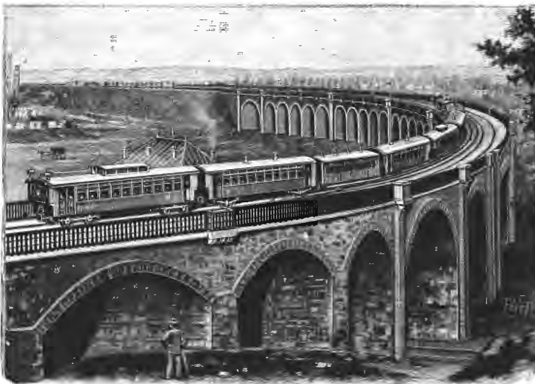
Рис. 2. Общій видъ поѣзда электрической дороги.
