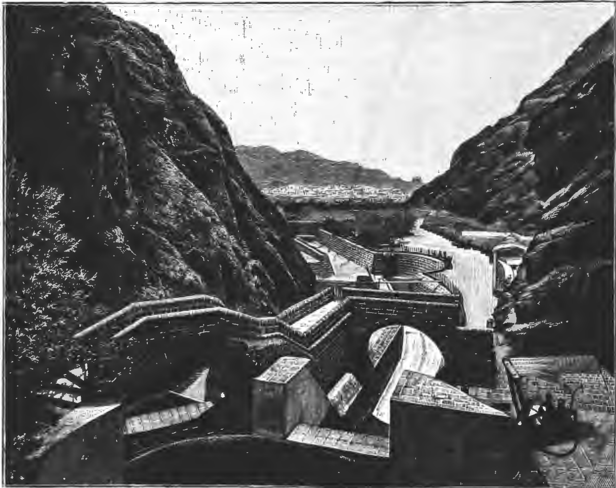
Водоемы для сохраненія дождевой воды подъ Аденомъ (въ южной Аравіи). По фот. грав. Бонгъ.
