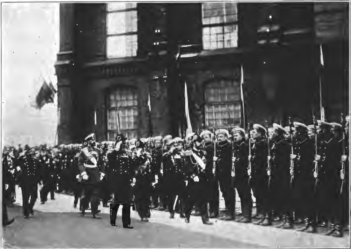
Торжественный спускъ на воду эскадреннаго броненосца „Князь Суворовъ“ на Балтійскомъ судостроительномъ заводѣ. Государь Императоръ проходитъ вдоль фронта почетнаго караула, выстроившагося у эллинга. По фот. К. Булла авт. «Нивы».
