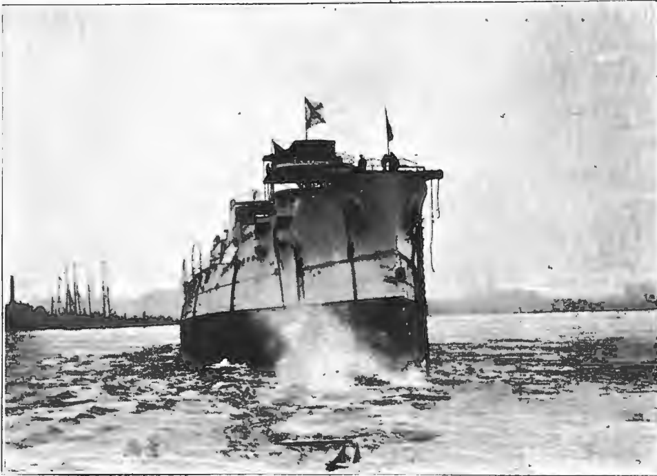
Эскадренный броненосецъ „Князь Суворовъ“, спущенный на воду 12-го сентября г. г. съ Балтійскаго судостроительнаго завода. По фот. К. Булла авт. «Нивы»
