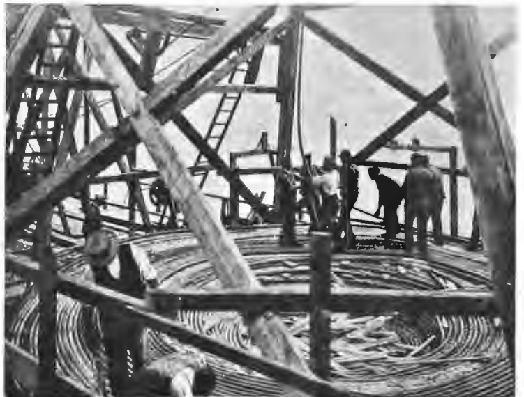
Подводная телефонная линия Боденского озера. Укладка кабеля на палубѣ парохода.
