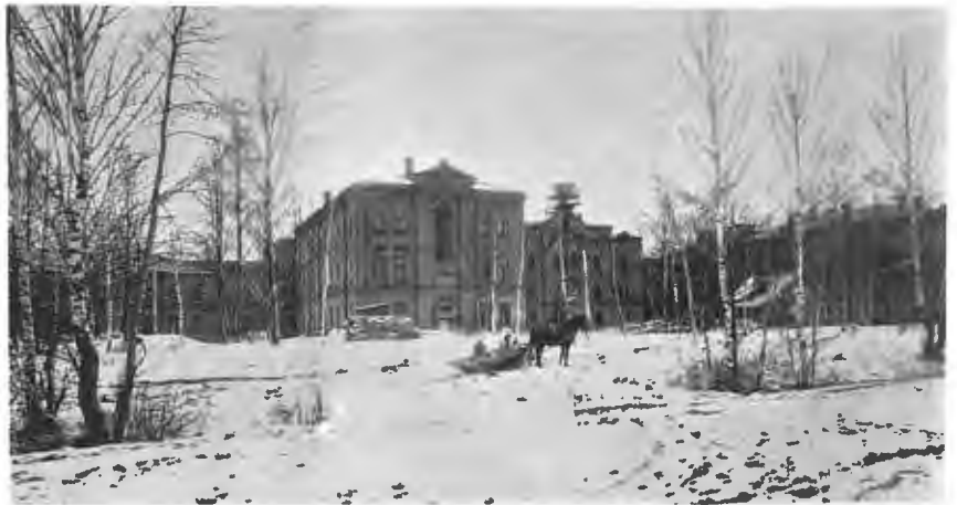
Зданіе открытой 25 октября с. г. окружной психіатрической лѣчебницы въ Подольскомъ уѣздѣ, Московской губ. По фот. П. Комова авт. «Нивы».
