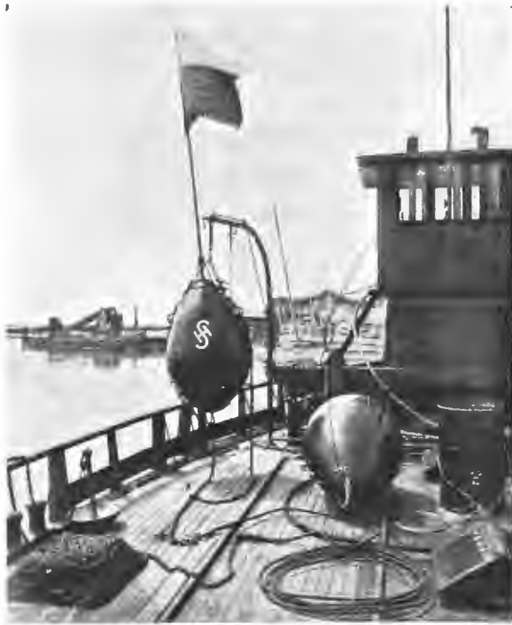
Подводная телефонная линия Боденского озера. Баканы, которыми отмѣчается направление кабеля по озеру.
