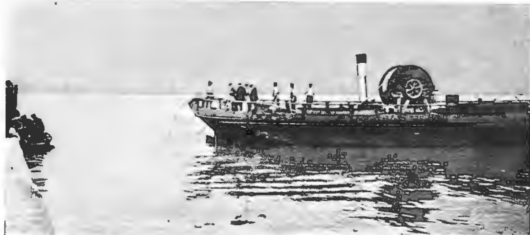
Подводная телефонная линия Боденского озера. Укладка прибрежной части кабеля у Романсгорна.
