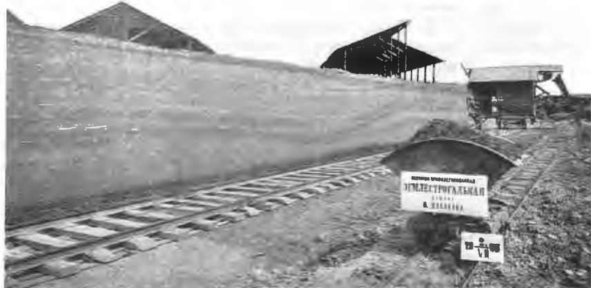
Землестрогальная машина Ѳ. А. Полякова-Ковтунова, работающая на кирпичномъ заводѣ «Звѣзда», и тачки съ глиною, которая въ нихъ нагружена машиною.
