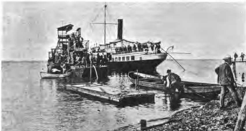
Подводная телефонная линия Боденского озера. Укладка прибрежной части кабеля у г. Фридрихсгафена.
