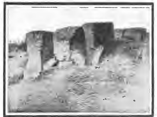
Фундаментные столбы одного изъ дворцовъ Навуходоносора.
