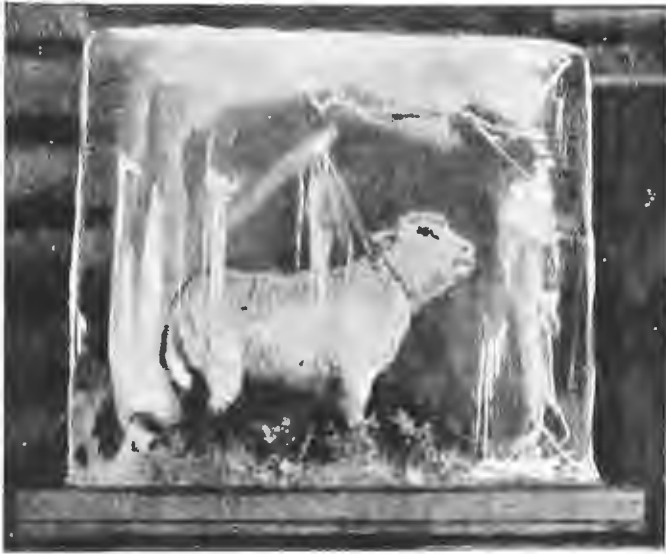
«Лондонскіе холодильники». Рис. 1. Цѣлая туша ягненка, замороженная въ водѣ. (Сфотографирована вмѣстѣ съ глыбою льда, въ которой туша вморожена).
