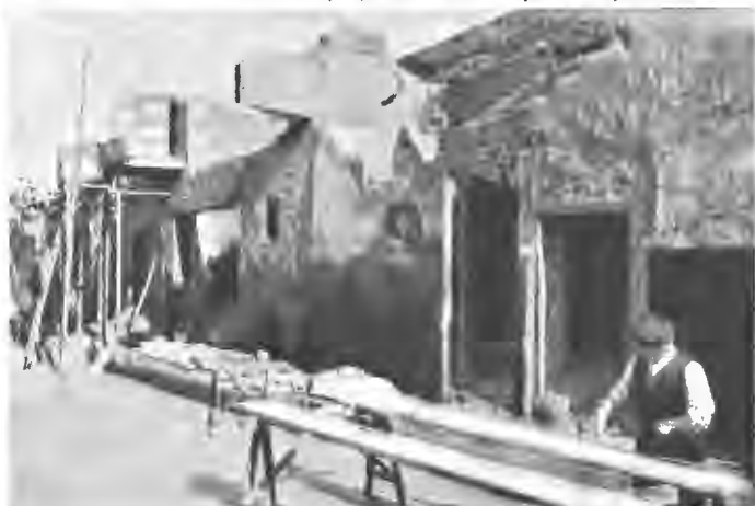
Древняя дорога, вновь увидѣвшая свѣтъ: „улица Изобилія“ съ ея домами, украшенными балконами (послѣ раскопокъ).
