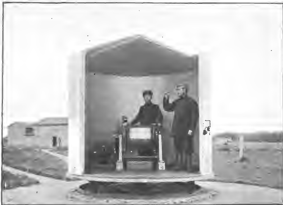
Желѣзный вращающійся павильонъ съ электрической лебедкой для подъема змѣвъ. На валу лебедки намотано около 14 километровъ стальной проволоки, къ которой прикрѣплены змѣи.
