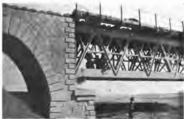
Подготовка железнодорожного моста к взрыву; между ферм закладываются пироксилиновые шашки, а от них проводится на далекое расстояние шнур-воспламенитель.
