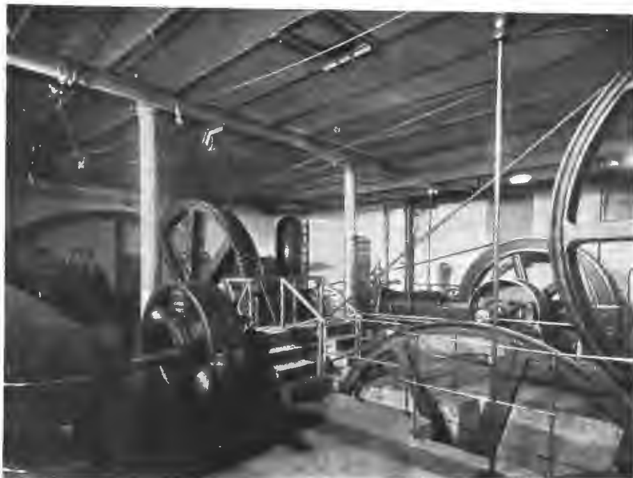
Цѣпная желѣзная дорога въ Тифлисъ. Машинный залъ съ динамомашинами. По фот. Г. Ольшанскаго, авт. «Нивы».
