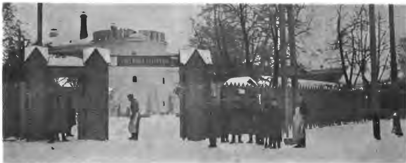
Пересыльная тюрьма. Тюремные больницы. (Уголь Лёсной ул.). Кровавые дни в Москвѣ. По фотографіямъ В. Грѣбова и нашего корреспондента К. К. Булга.
