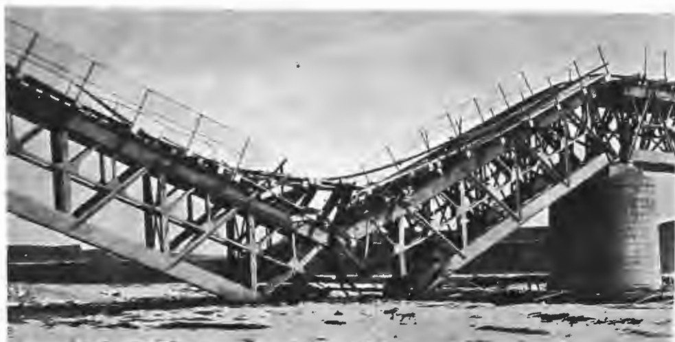
Разрушенный русскими железнодорожный мостъ близъ ст. Шаумяотзы; взорваны (какъ и въ другихъ случаяхъ) лишь фермы, а каменные устои оставлены не разрушенными.
