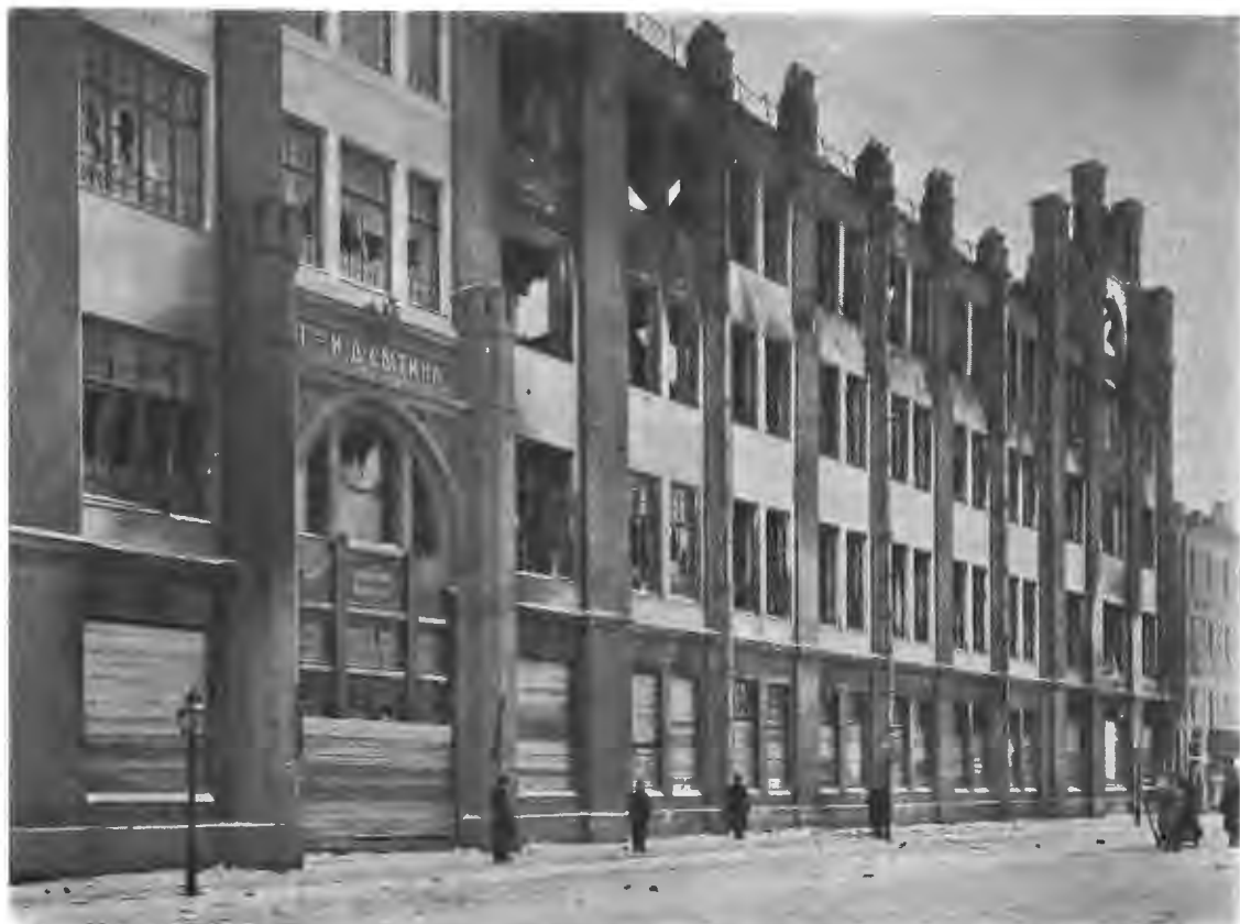
Кровавые дни въ Москвѣ. Домъ Товарищества И. Д. Сытина (на Вальной улицѣ). Въ виду того, что въ зданіи укрылись революціонеры, стрѣлявшіе изъ оконъ въ войска, артиллерія стала его обстрѣливать: вслѣдъ за тѣмъ возникъ пожаръ. По фот. В. Грибова.
