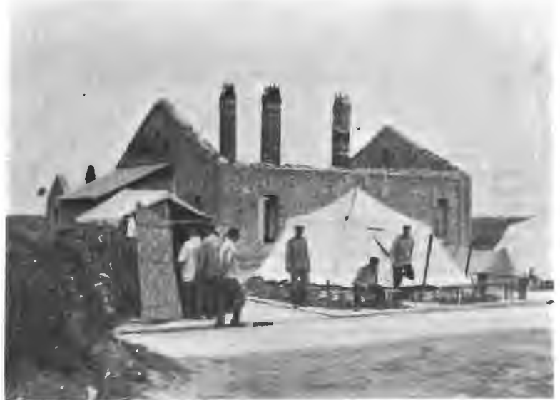
Разрушенный постъ пограничниковъ.
