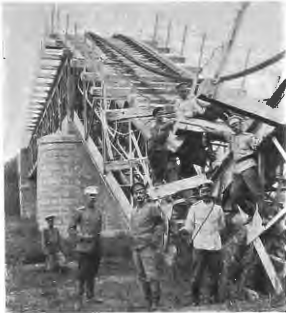
У разрушенного моста.
