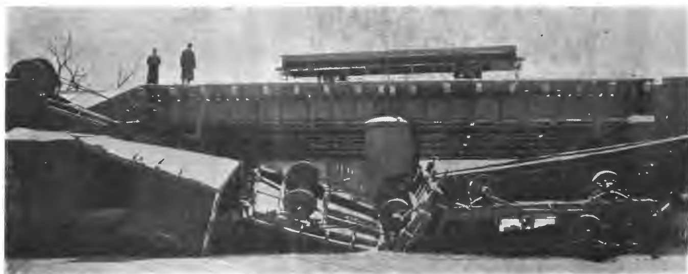
Барикады, сооруженные из вагонов у Курского железнодорожного моста (на Золоторожской улице).
