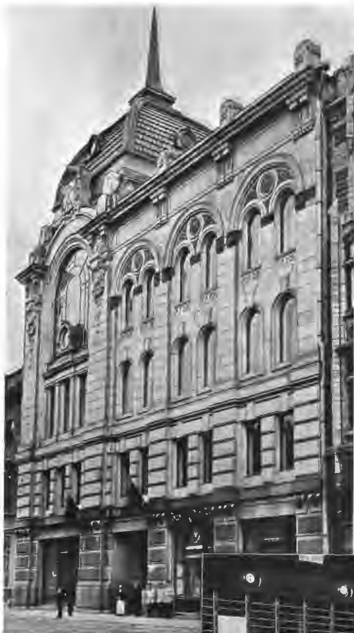
Новая телефонная станция въ С.-Петербурѣ. Фасадъ зданія станціи на Морской ул.
