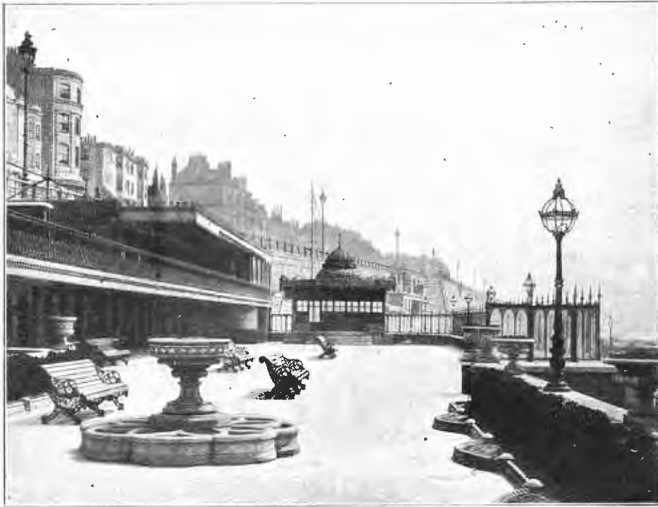
Рис. 2. Боковой фасадъ зданія акваріи съ колоннадою. Съ фот. авт. «Нивы».
