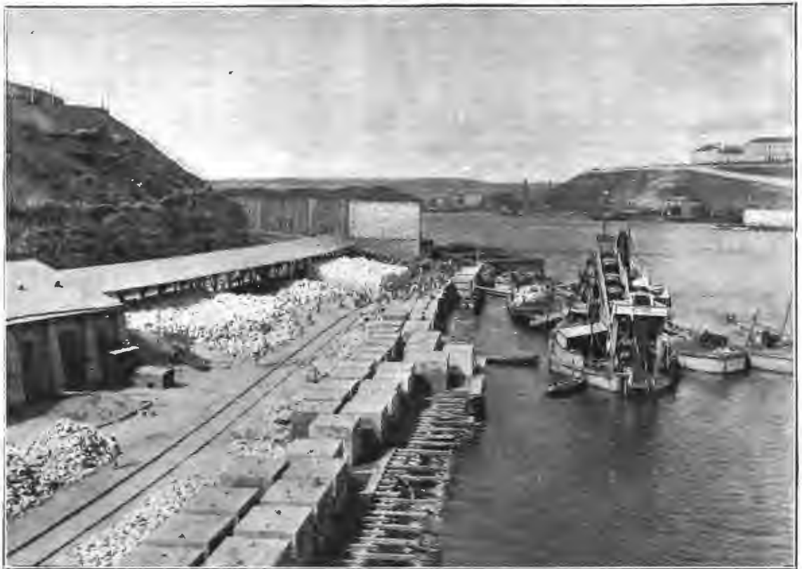
Новая Царская пристань въ Севастополѣ во время ея сооруженія. По фот. авт. «Нивы».
