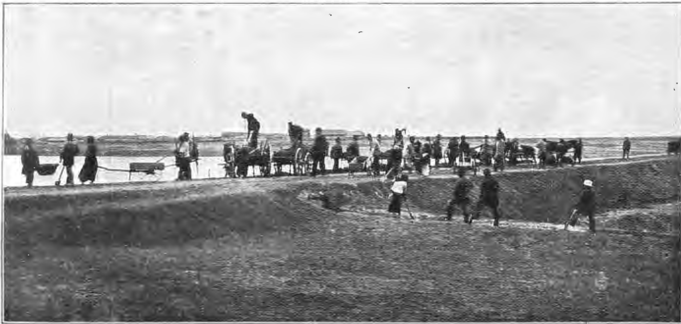
Общественныя работы для нуждающихся крестьянъ. Устройство плотины въ с. Чичмѣ (бессарабской губ.). По фот. авт. «Нивы».
