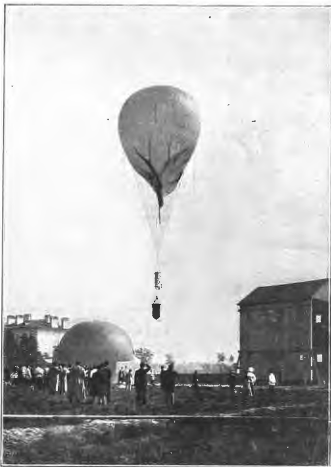
Рис. 1. Подъемъ шара съ метеорологическими самопишущими приборами.
