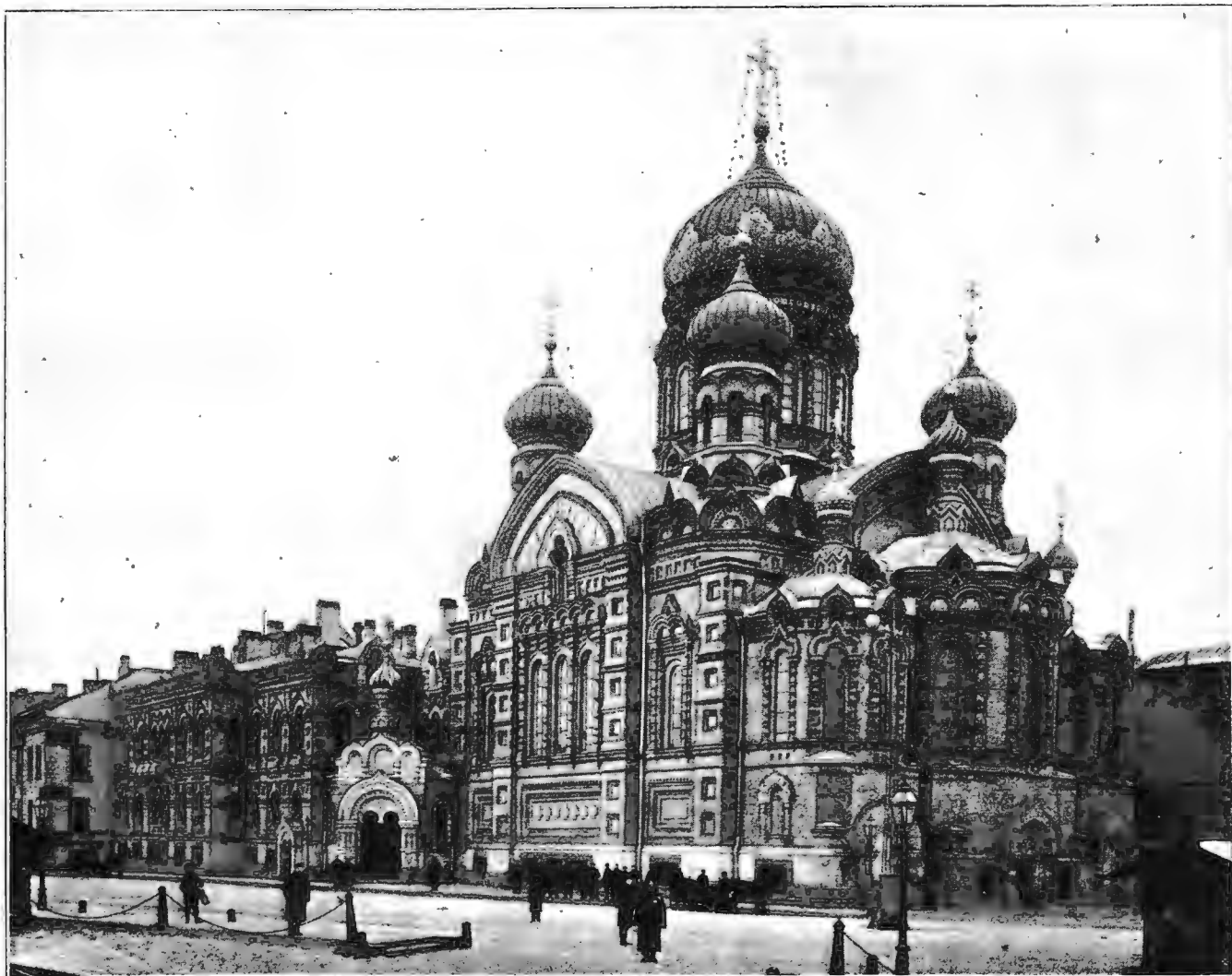
Новая церковь при подворьѣ Киево-Печерской Лавры въ С.-Петербурѣ, на углу 15 линіи и набережной Невы. Съ фот. К. Булла авт. „Нивы“.
