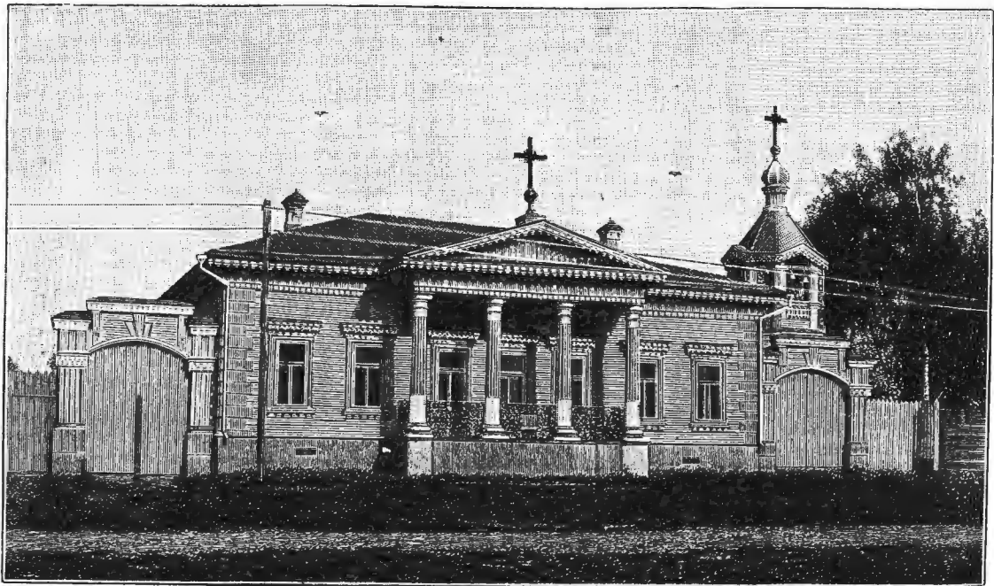
Г. Чембарь, пензенской губ. Царская церковь послѣ ремонта 1884/85 года. Съ фот. Путова гр. М. Рашевскій.
