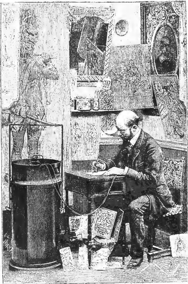
Рис. 1. Способъ употребленія аппарата. Управление термографомъ, какъ карандашомъ. Слева резервуаръ для воздуха. Вокругъ—образцы пирографуры.
