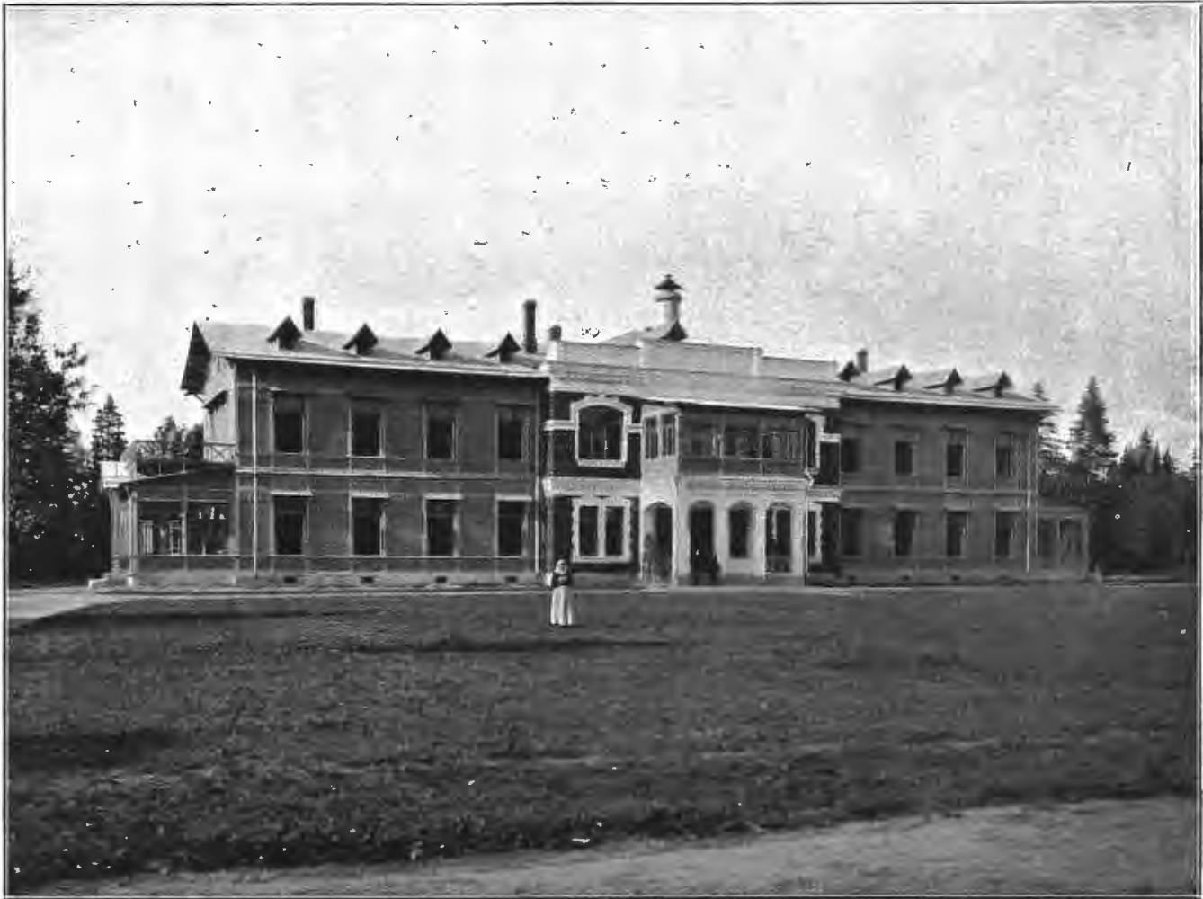
Таицкая санаторія. Фасадъ новаго корпуса, въ которомъ помѣщается мужское отдѣленіе санаторіи. По фот. И. Пономарева, авт. «Нивы».
