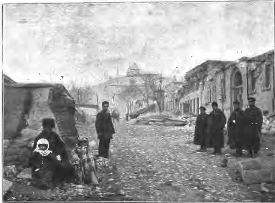
Землетрясеніе въ Шемахѣ, 31-го января 1902 г. Татарская улица. По фот. Ю. Зелинскаго авт. «Нивы».
