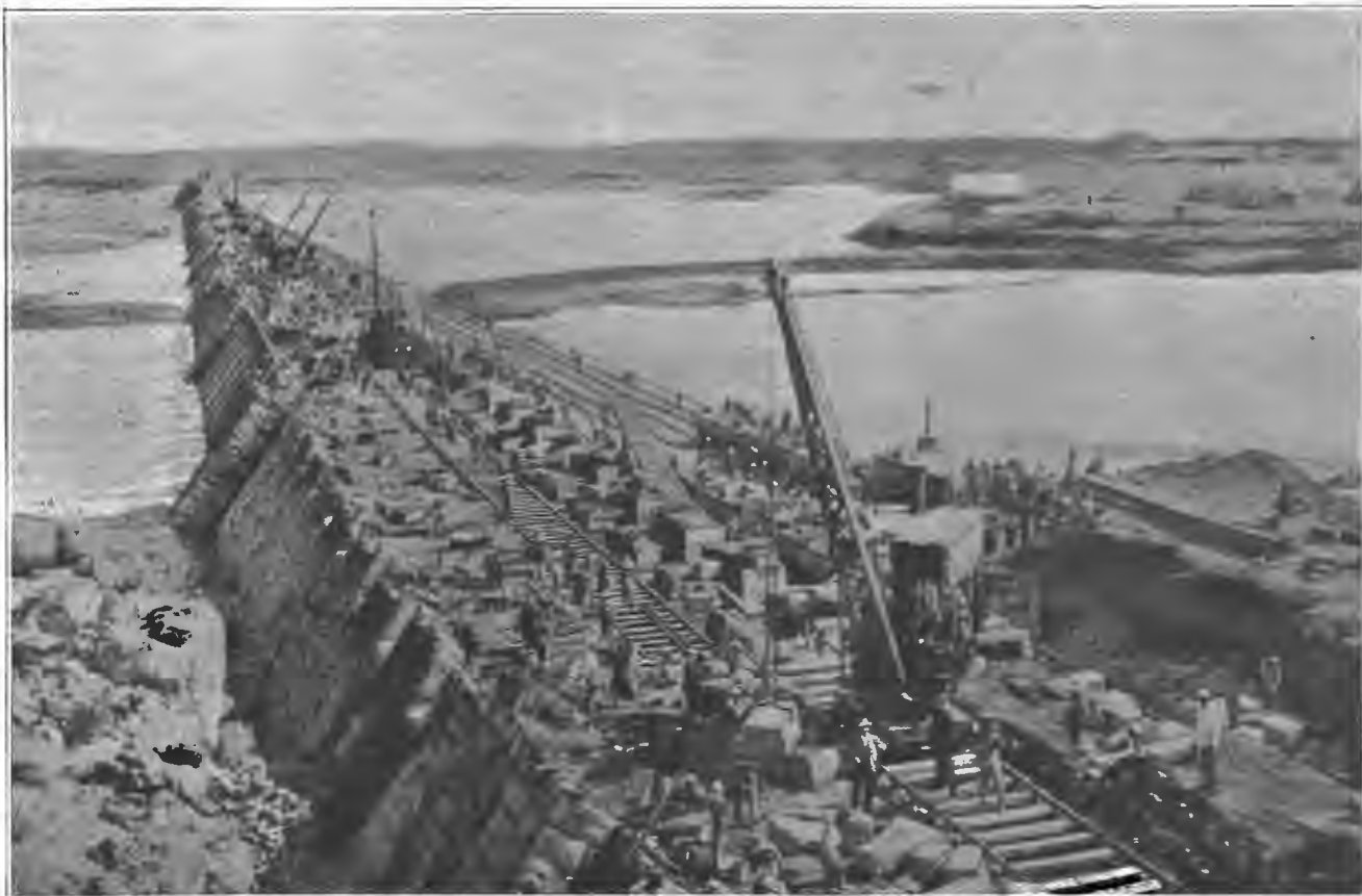
«Ассуанская плотина и островъ Филэ». Общій видъ работъ по устройству плотины. По фот. Беато авт. «Нивы».
