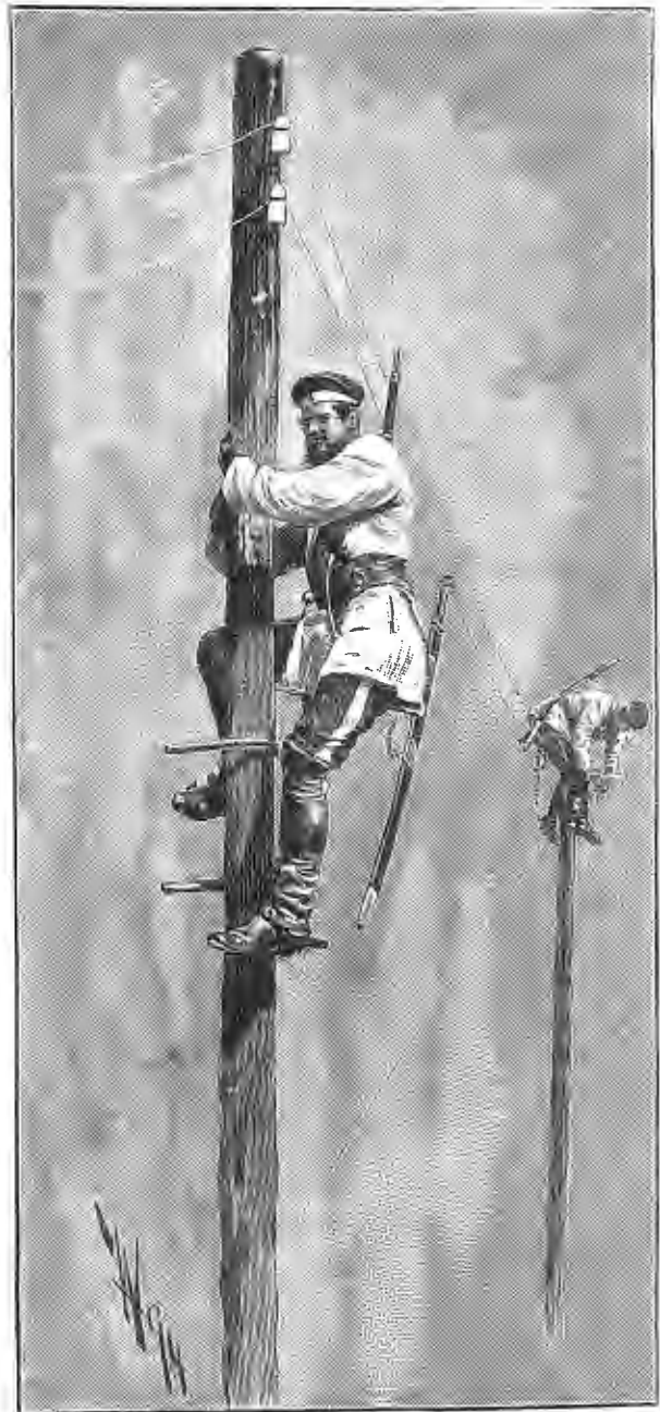
Саперная служба нашей кавалеріи. Влѣзаніе на телеграфныя столбы посредствомъ желѣзныхъ шкостей. Съ рис. А. Вальда грав. Іерике.
