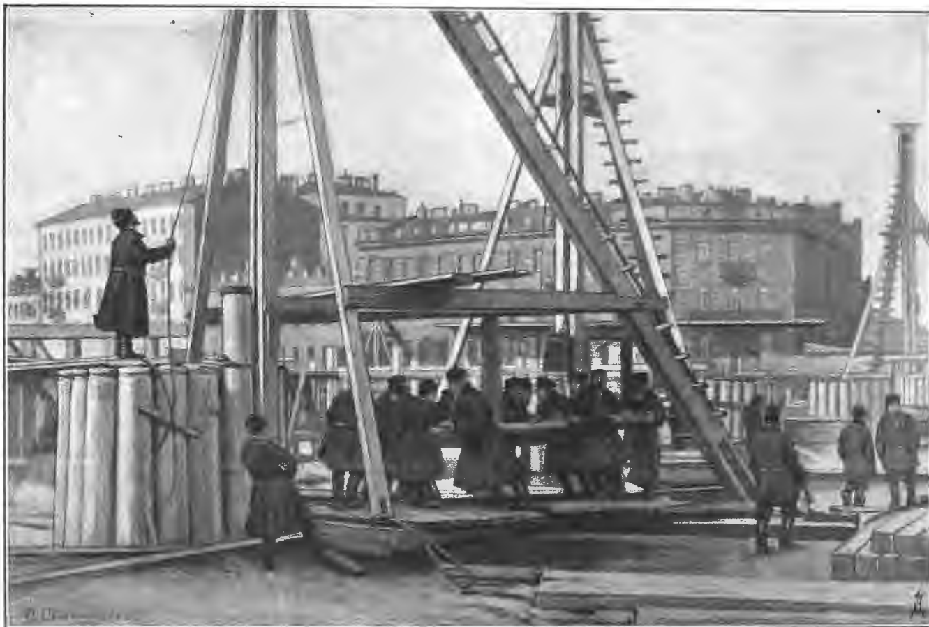
Новый Мытнинский мостъ черезъ Малую Неву въ СПб. Забивка свай. Ориг. рис. (собств. „Нивы“) Сильвановича, автотипія Демчинскаго.
