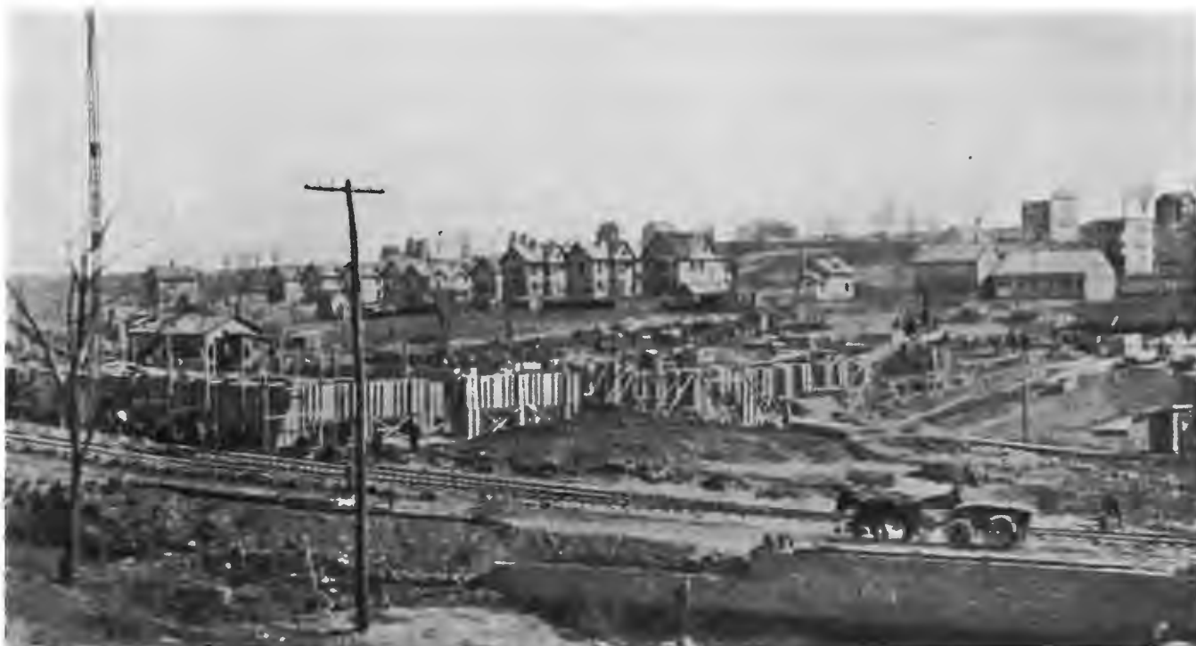
Бриджпортъ 15-го марта 1915 г. Мѣсто, очищенное подъ постройку зданій оружейнаго завода.
