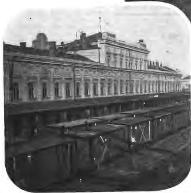
Тернополь. Желѣзнодорожный вокзалъ.
