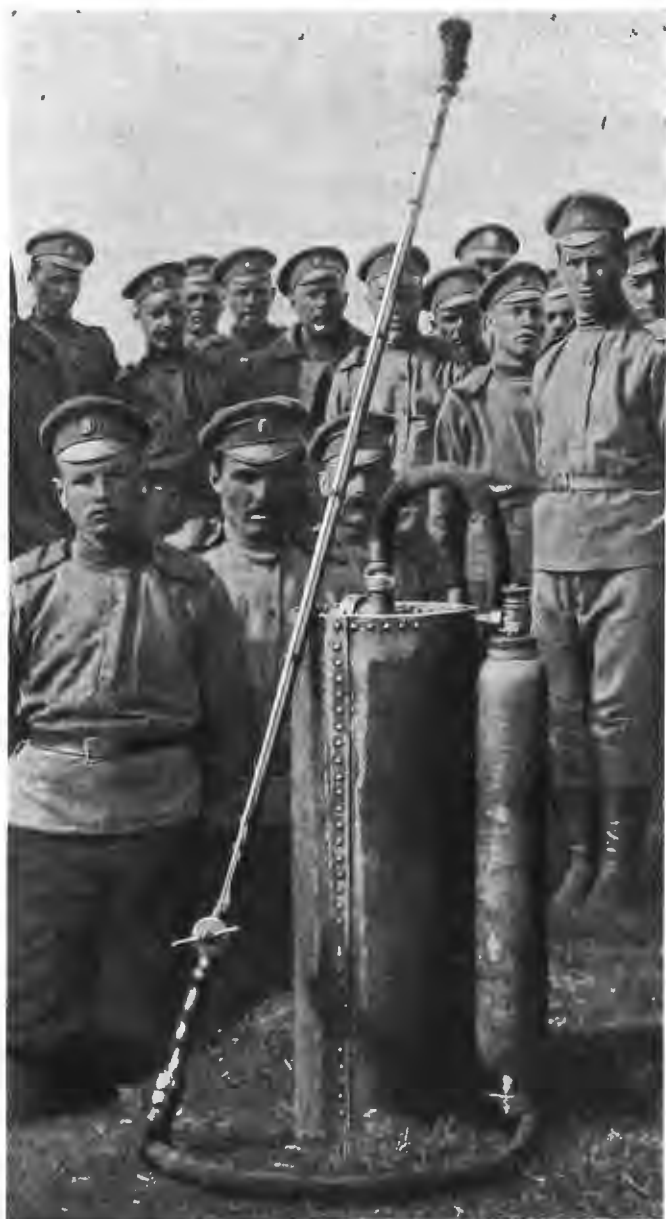
Германский огнеметъ. Изображенный на фотографии аппаратъ служитъ германцамъ для выбрасыванія струи горячей жидкости въ противника. Пламя выбрасывается на расстояние до 100 шаговъ вверхъ, широкая сторона котораго достигаетъ до 60 шаговъ. При этомъ вверхъ поднимаются клубы густого черного дыма. Аппаратъ дѣйствуетъ всего лишь 30—40 секундъ и рассчитанъ почти исключительно на моральное дѣйствіе.
