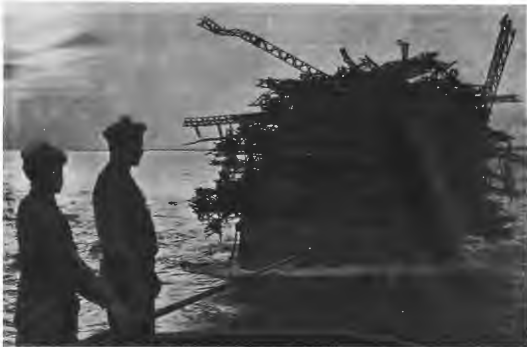
На Салоникскомъ фронтѣ. Обломки цеппелина L. 85, подбитаго англичанами во время его налета на Салоникскій рейдъ. Союзническіе инженеры вытащили ихъ изъ воды и отправили на берегъ для сборки изъ этого алюминиеваго скелета поверженнаго врага новаго дирижабля.
