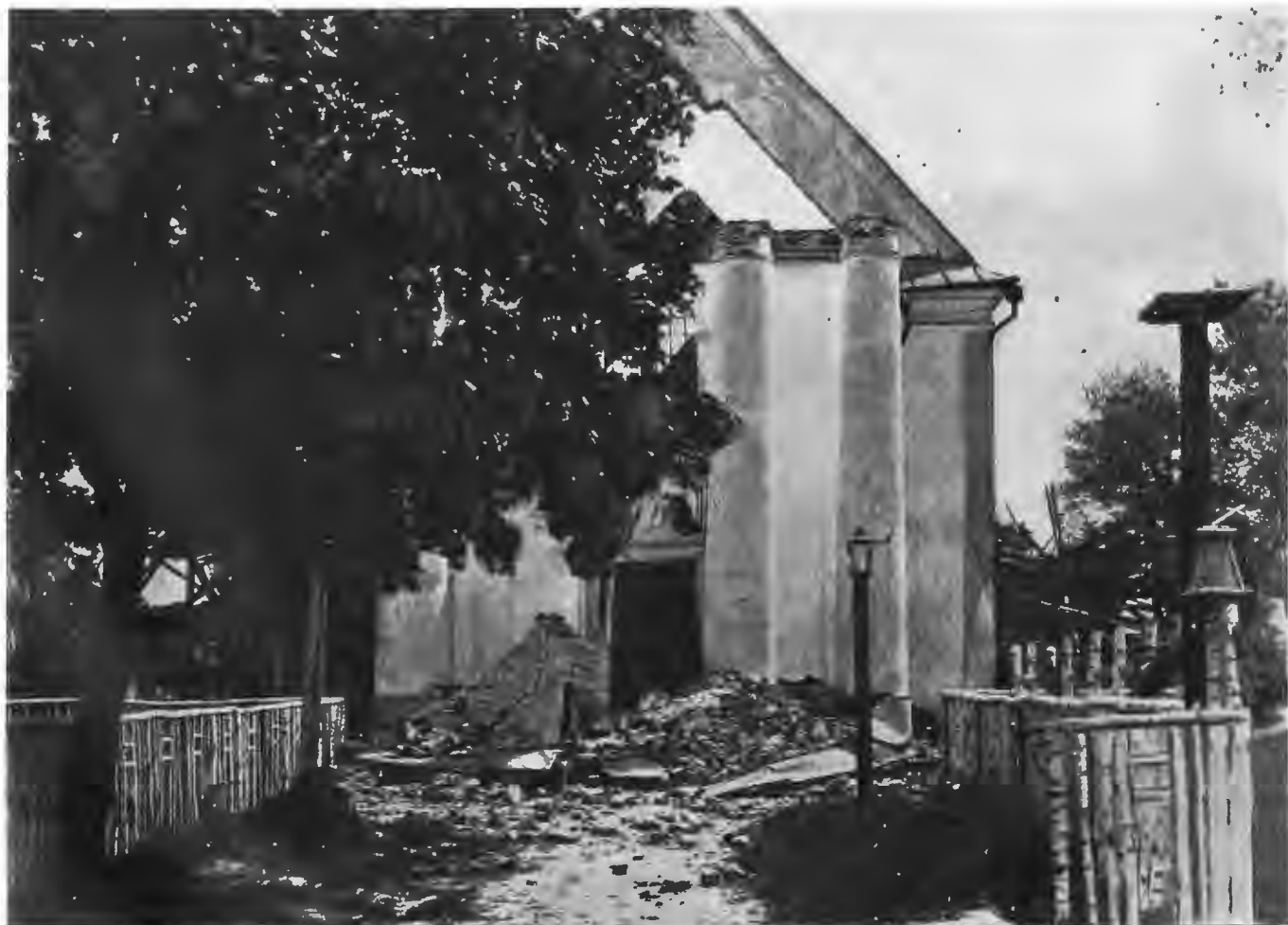
Наше наступленіе на юго-западномъ фронтѣ. Мѣстечко Колки. Разрушенная церковь.
