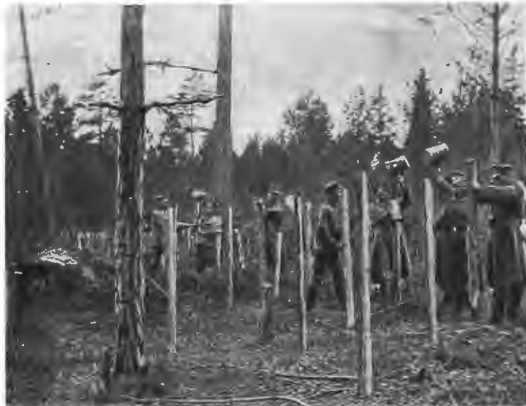
Устройство проволочных заграждений около опорного пункта.
