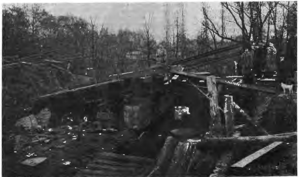
На сѣверномъ фронтѣ. Разрушенія около станціи Я...
