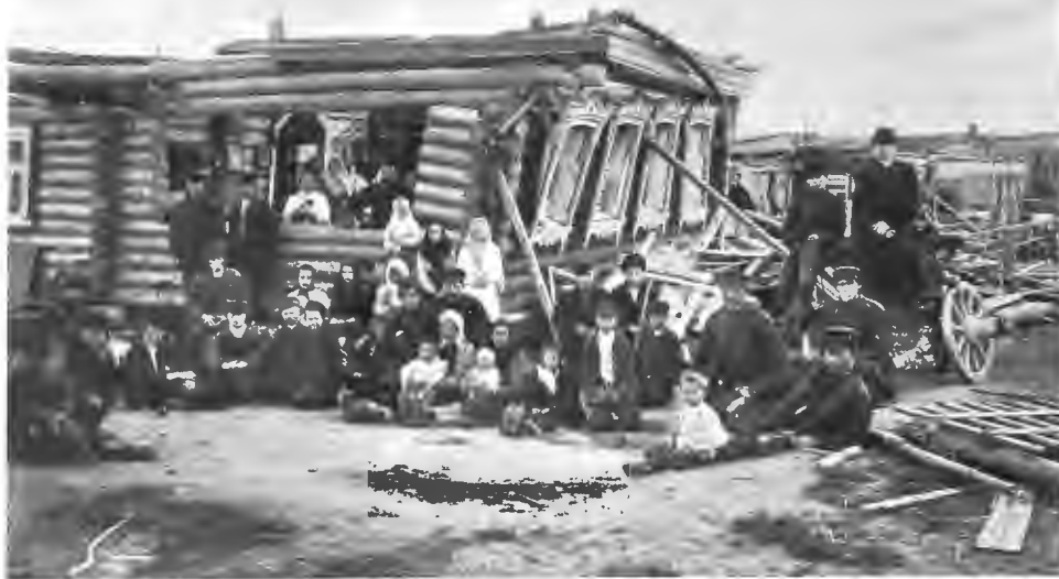
Ураганъ въ Москвѣ и подъ Москвой. Разрушенная чайная Генералова въ дер. Чагино. По фот. авт. «Нивы».
