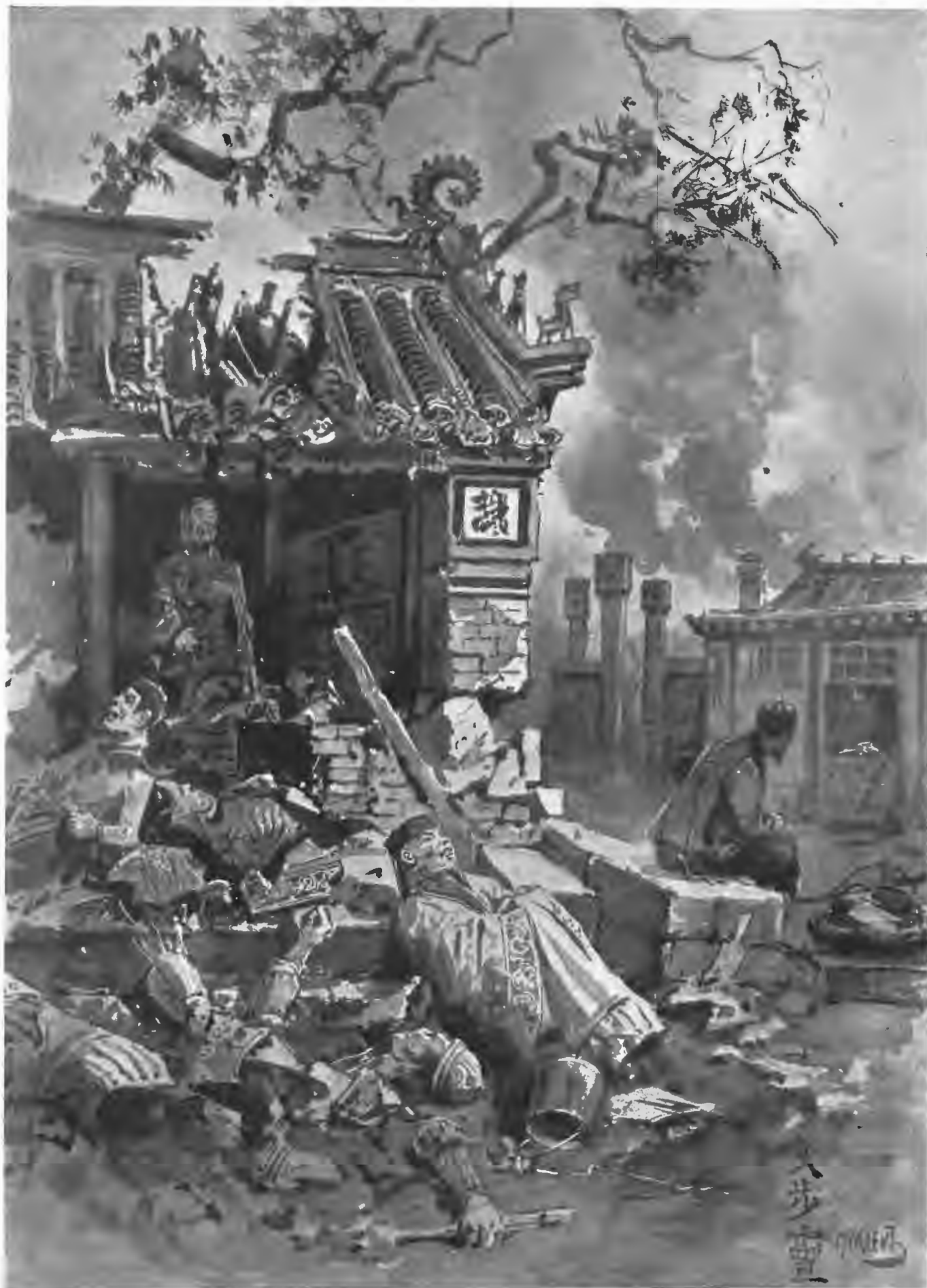
Разрушенная китайская кумирня. Рисунок нашего специальн. корресп. В. Табурина, авт. «Нивы».
