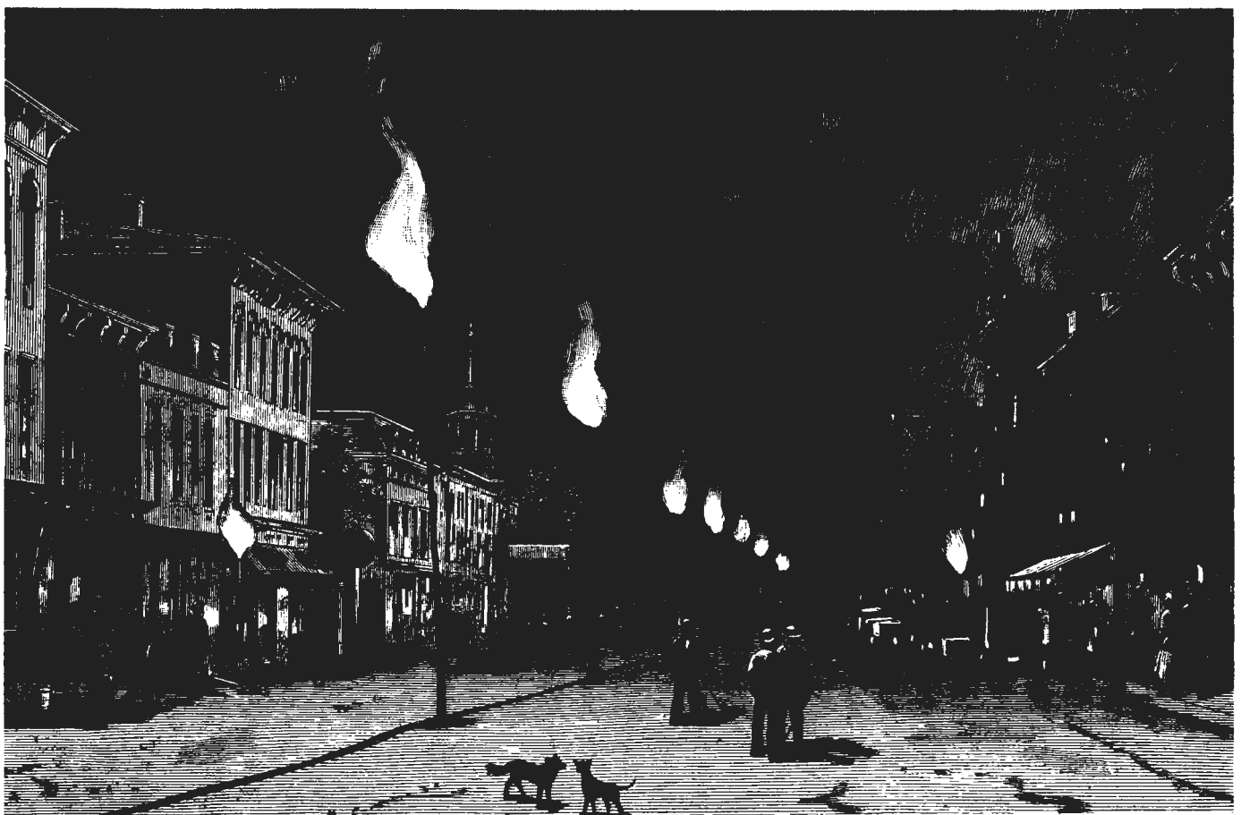
Освѣщенiе улицъ необработаннымъ газомъ, прямо изъ копей, въ г. Финдлей (Сѣвер. Америки).
