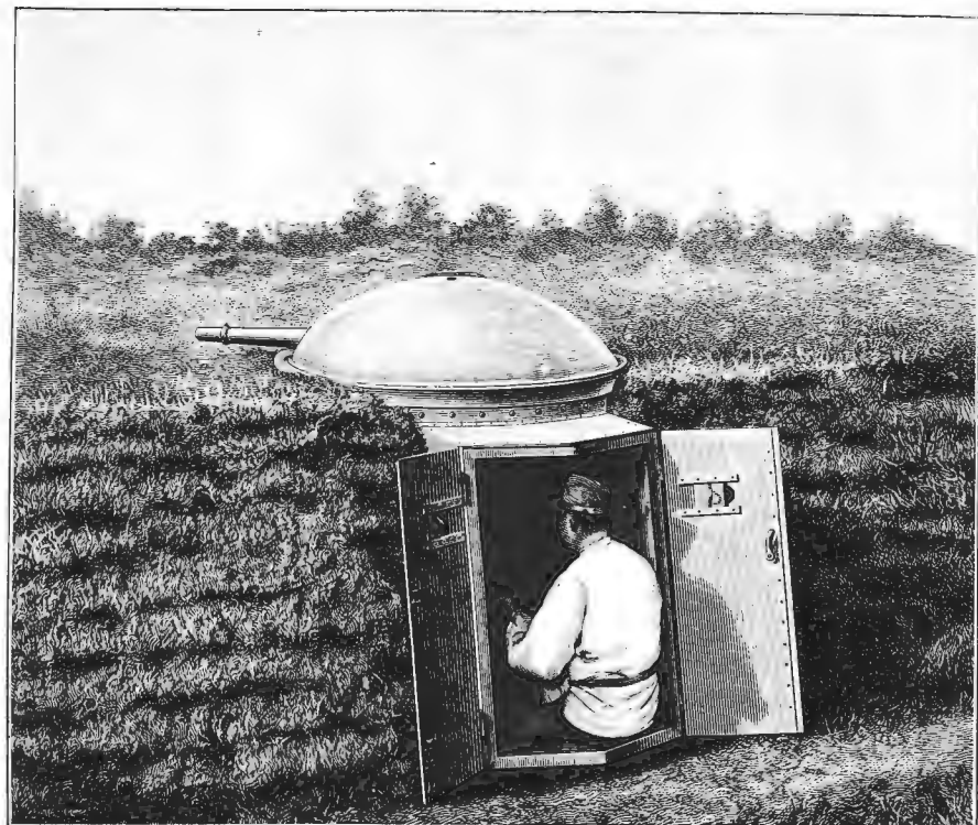
Рис. 7. Перевозный панцирный лафетъ для скорострѣльной 3,7 центиметр. пушки въ земляномъ укрѣпленіи.
