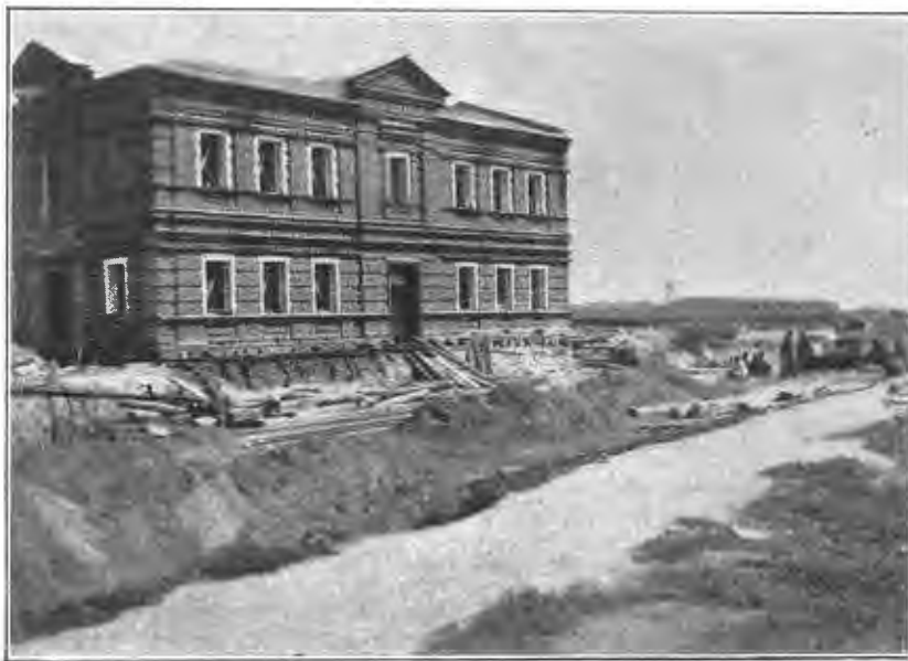
Домъ въ Москвѣ, перемѣщаемый по проекту инженера Федоровича. Съ фот. автотипія „Нива“.
