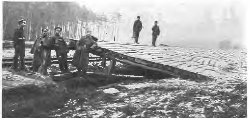
Сооруженію временной платформы для тяжелыхъ орудій.
