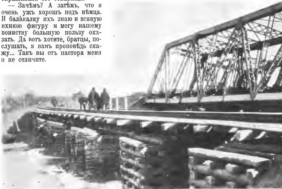
Мостъ на шпалахъ, выстроенный вмѣсто желѣзнаго моста, разрушеннаго непріателемъ.
