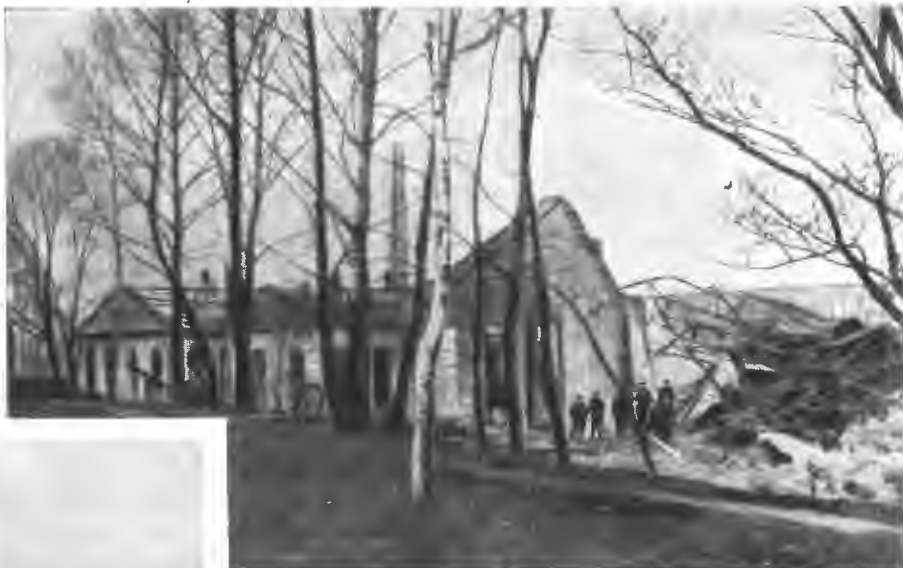
Радомъ. Разрушенная бомбардировкой желѣзнодорожная мастерская.
