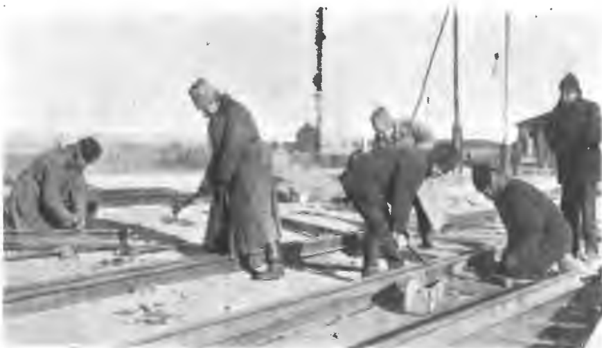
Исправленіе нижними чинами желѣзно-дорожного батальона пути, испорченнаго германцами.
