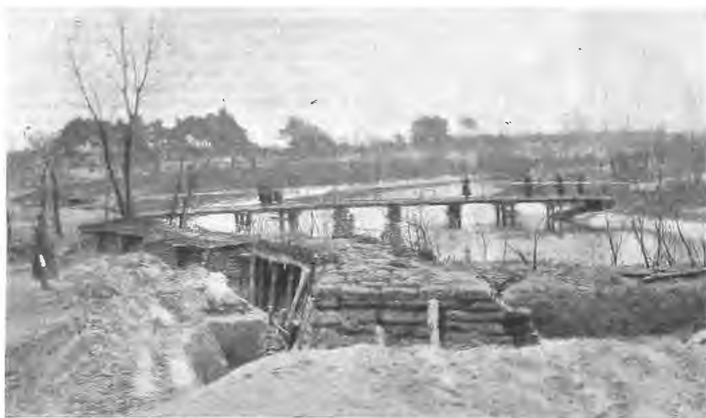
Мостъ и окопы на берегу рѣки Бзуры.
