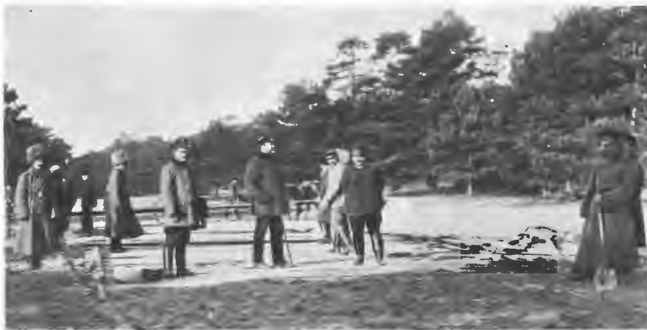
Постройка дороги для автомобилей.
