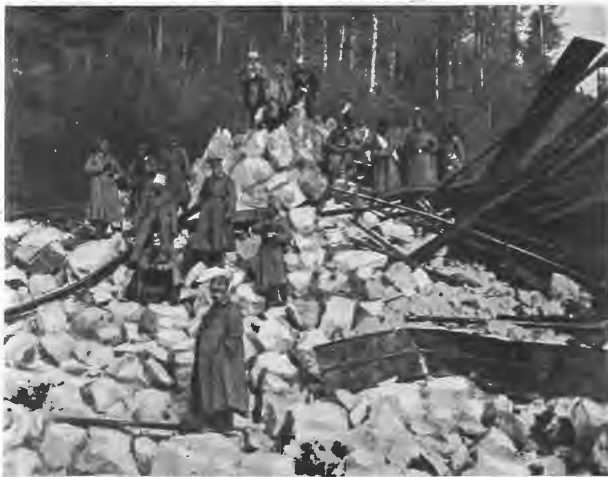
Наши офицеры у разрушеннаго австрійцами желѣзнодорожнаго моста въ Карпатахъ.
