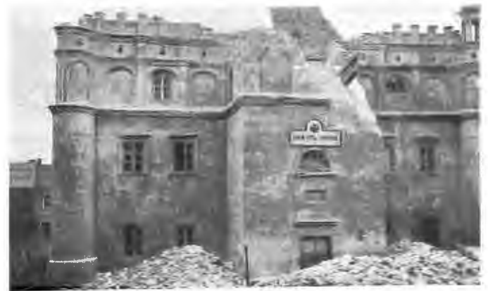
Зданіе магистрата въ городѣ Шидловцѣ, поврежденное бомбардировкой.
