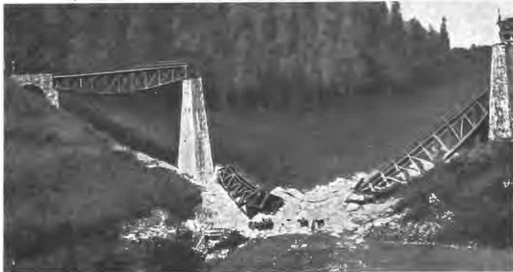
Въ Карпатахъ. Желѣзнодорожный мостъ, разрушенный австрійцами.
