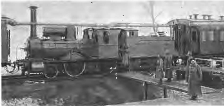
Поезд-бани и прачечная в действующей армии. Парь передается по соединительной трубѣ въ вагонъ-баню и въ вагонъ-прачечную.
