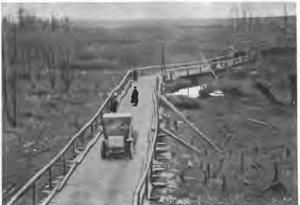
Во Фландріи. Деревянный мостъ въ 500 метровъ длины, выстроенный нѣмцами на болотѣ.
