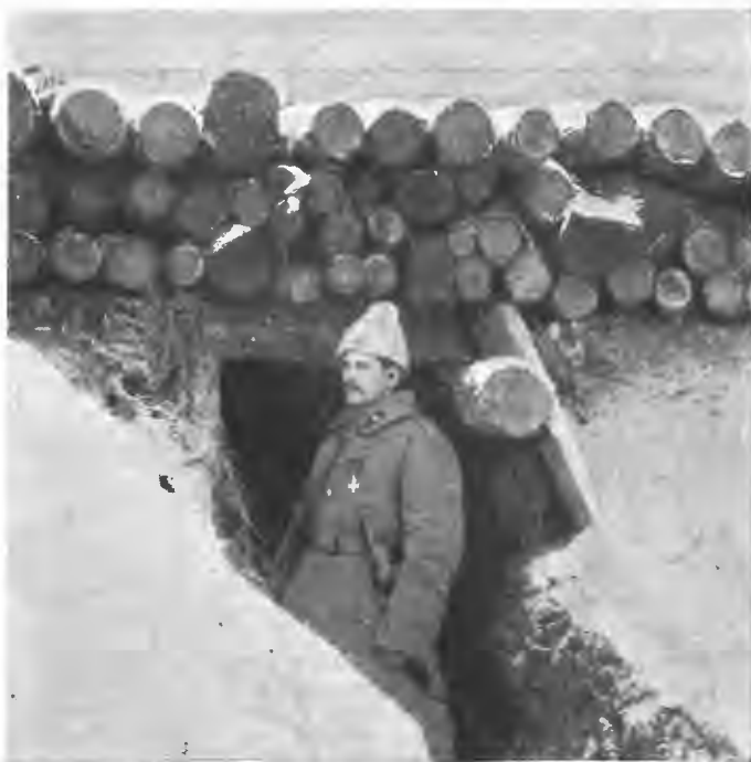
Блиндажъ, выдерживающій обстрѣлъ германскихъ тяжелыхъ снарядовъ.
