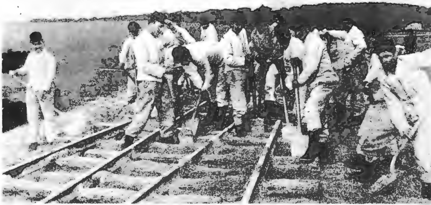
На западном фронте. Возстановление железнодорожного пути, разрушенного отступившими германскими войсками.
