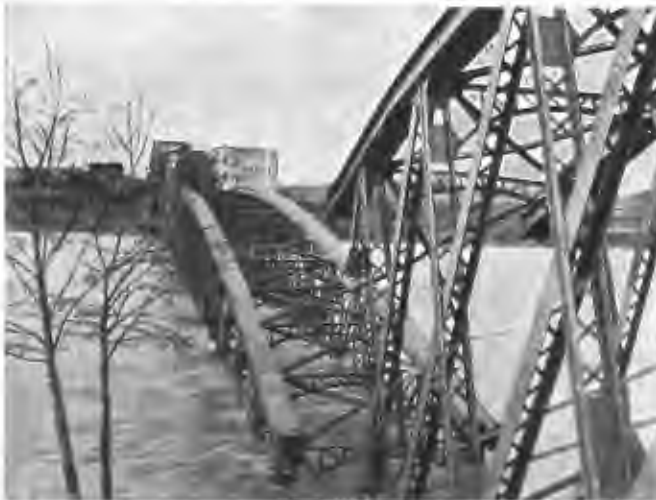
Мостъ разрушенный австрійцами при отступленіи.
