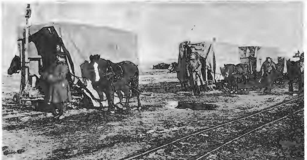
Узкоколейная желѣзная дорога съ конной тягой. Вагонетки обтянуты парусиной.
