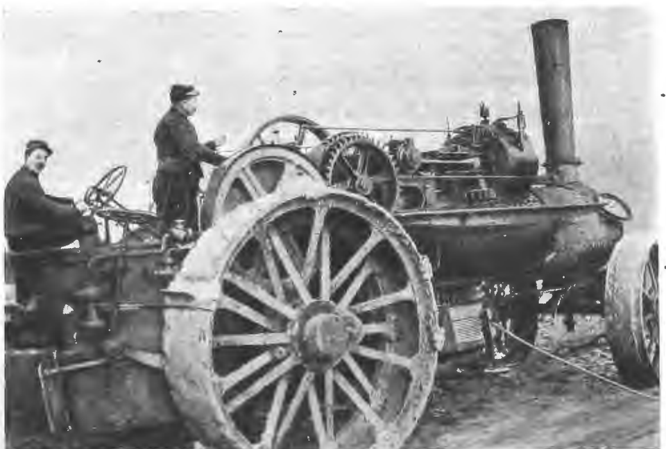
Французская машина для выравниванія почвы, изрытой снарядами.
