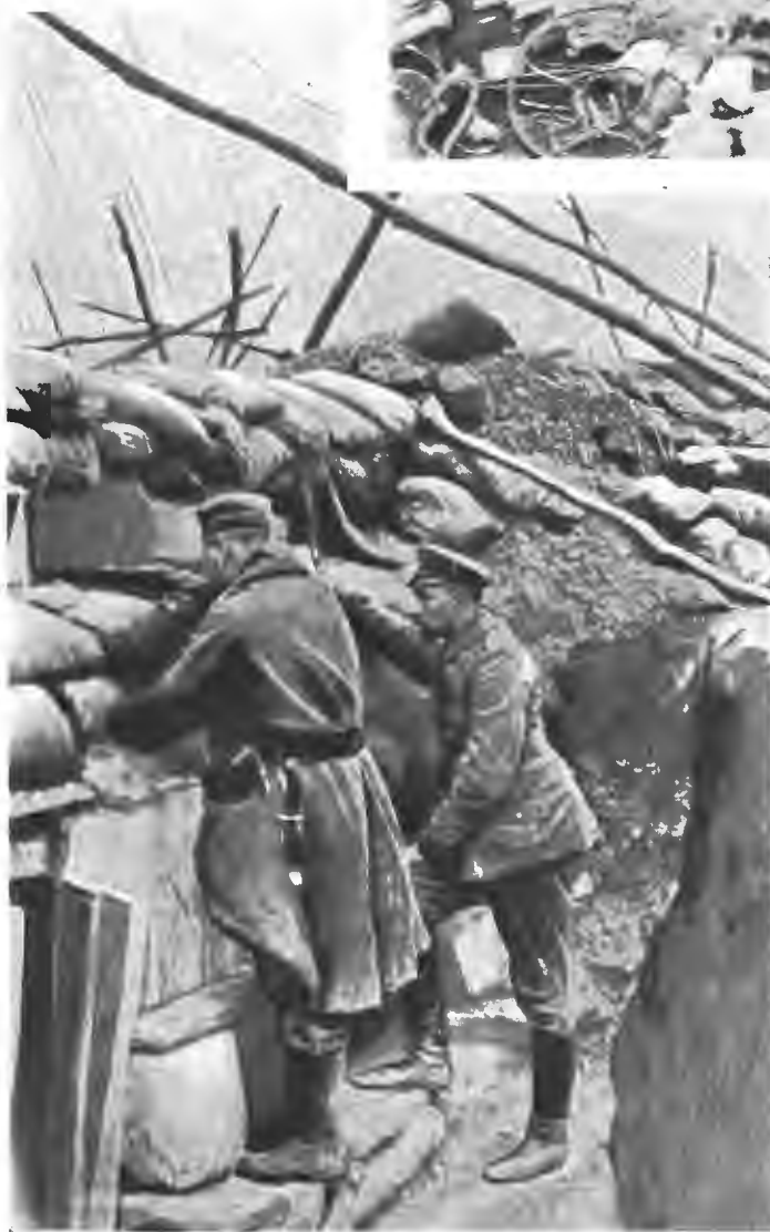
Новое нѣмецкое изобрѣтеніе. Проволочная сѣтка у бруствера окопа для защиты отъ ручныхъ гранатъ.
