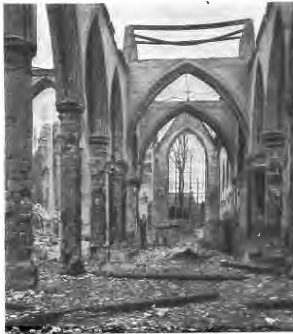
Внутренность разрушенной церкви въ Ньюпорѣ (Бельгія).
