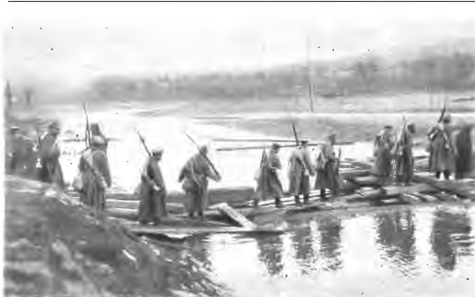
Переправа через рѣку.
